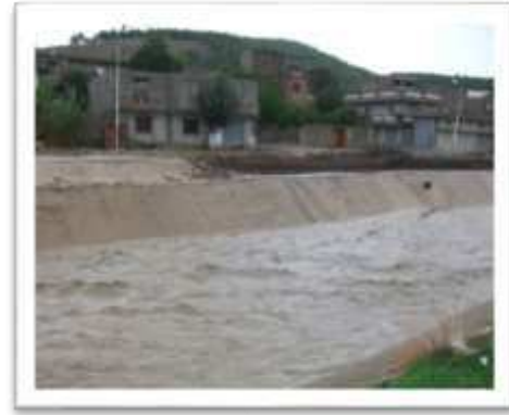
Photo 8: Etat d'oued El Klab après l'aménagement (2014) (Source : APC de Sigus)
