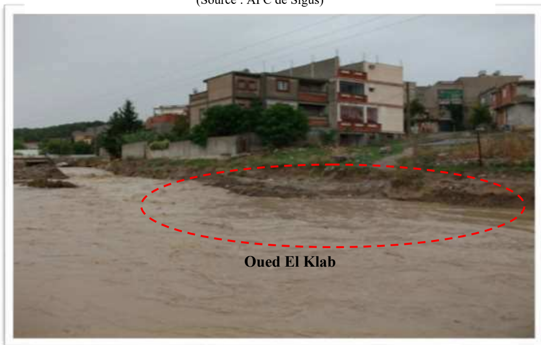
Photo 41 : Le sapement de berges d'oued El Klab (Photo prise par l'auteur 2014)
