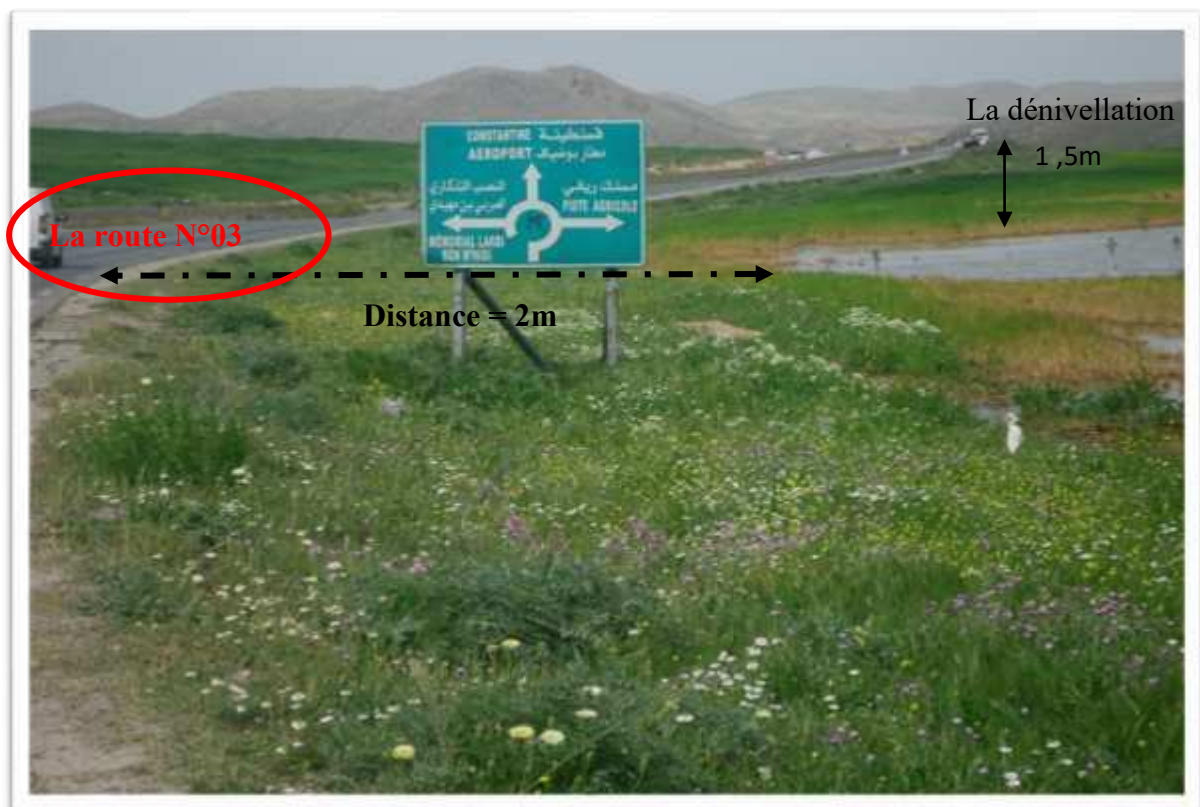
Photo 39 : Un tronçon d'inondation dans la route nationale N°03 (Photo prise par l'auteure janvier 2014)
