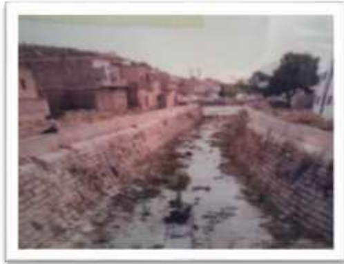
Photo 7 : Etat d'oued El Klab avant l'aménagement (Source : APC de Sigus(1980)
