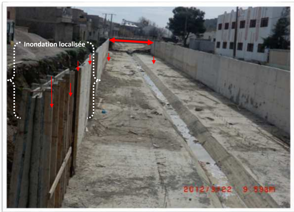
Photo 34 : Un pont de débordement dans la ville de Sigus (Source : APC Sigus 2012)
