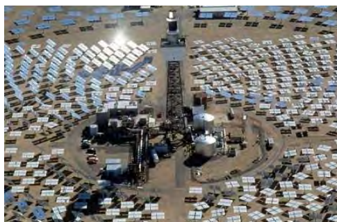
Figure II.6 : Système de centrale à tour
