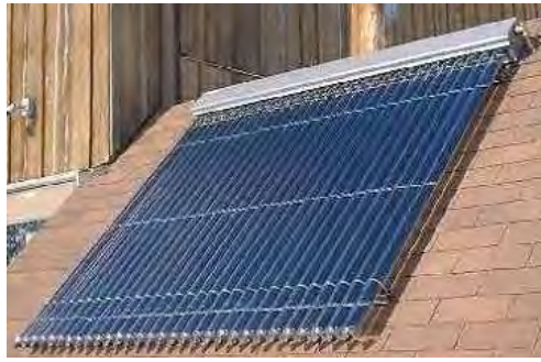
Figure II.3 : Capteur solaire à tubes sous vide
