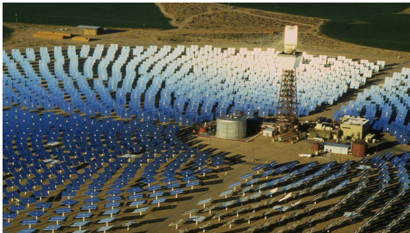
Figure 5 : Des panneaux solaires photothermiques [14].
