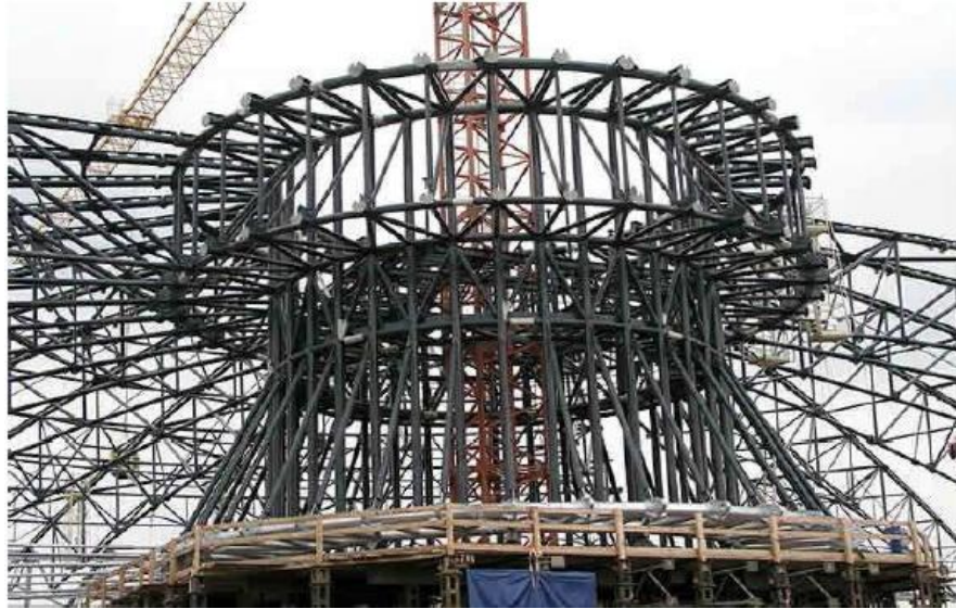
Figure. I.7. Construction de la cheminée
