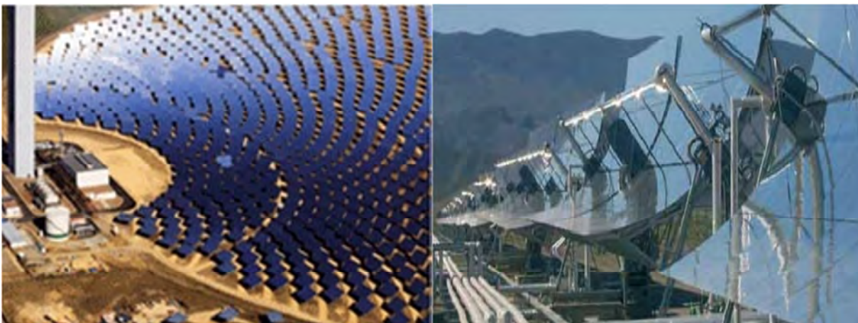
Figure I.6 capteur à chaudière fixe et concentrateur mobile
