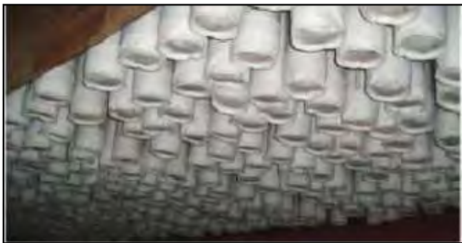
Figure III.1 : Exemple de filtre à manches et de matière filtrante utilisés dans une cimenterie du Royaume-Uni (CE, 2010, pp. 127)
