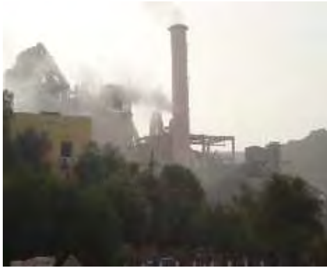
Photo V.1 : Ancienne cheminée avec électrofiltre (Source : Auteur 2011)
