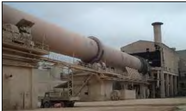
Photo IV.7 : Four de cuisson de la cimenterie (Source : Auteur, 2011)
