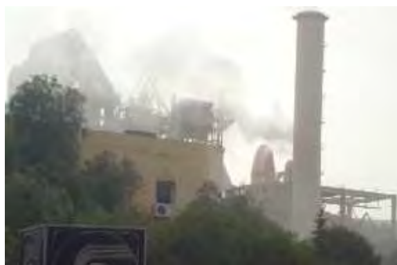
Photo IV.9 : Ancienne Cheminée avec filtre électrostatique. (source : Auteur 2011)
