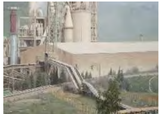
Photo IV.6 : Hall de stockage du cru (Source : Auteur, 2011)
