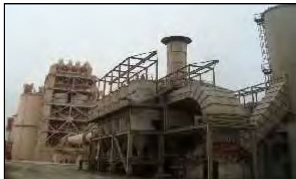
Photo IV.8 : Refroidisseur avec filtre à gravier (Source : Auteur, 2011)
