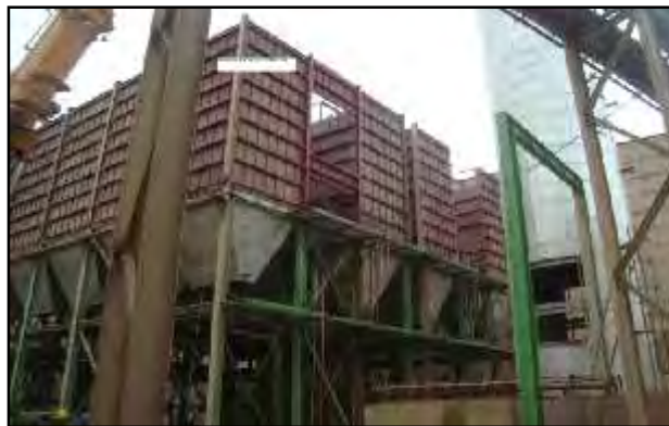
Photo VI.11 Montage du nouveau filtre à manche (source : Auteur, 2011)
