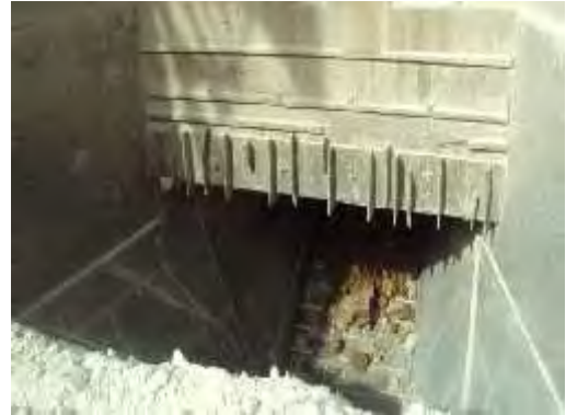
Photo IV.4 : Concassage des matières premières au niveau de la carrière (source : Auteur, 2011)
