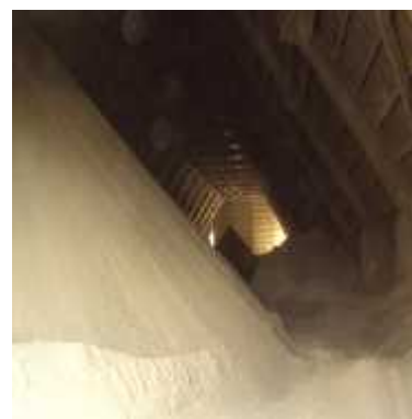
Photo V.7 : Intérieur du hall clinker (Source : Auteur, 2011)
