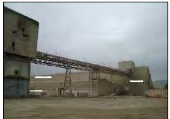
Photo V.5: Hall de stockage du clinker
