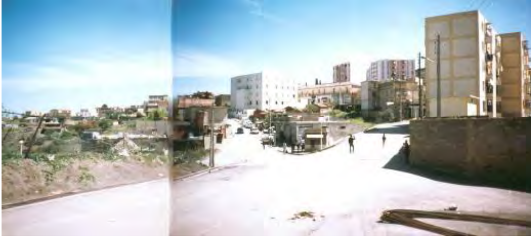
صورة رقم 31: الجمعة عقر التجمع العمراني مركز بني ورتيلان، تظهر العمارات الجماعية و كأنها مفصولة عن باقي البنايات مما ينم على الاعتناء بالجانب الكمي و تناسي الجانب الجمالي العمراني. المصدر: الباحث، ص 2004
