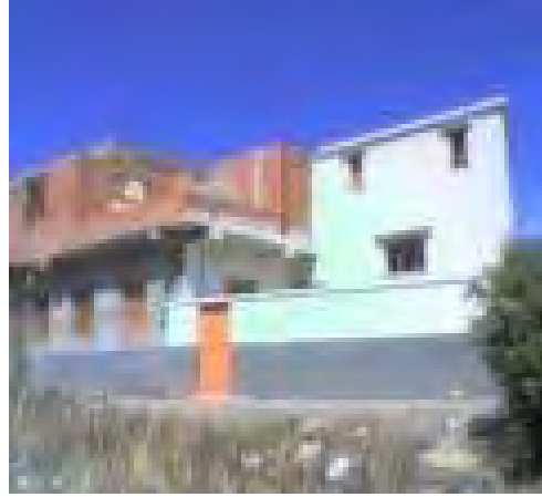
صورة رقم (54) : واجهة منزل العائلة النووية المنفصلة عن العائلة (ك.ب) ضمن النسيج العمراني بقرية منادس
