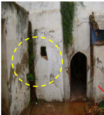
Les problèmes d'infiltration des eaux pluviales par endroits et des problèmes d'humidité ascendante ont provoqué la détérioration des enduits extérieurs.
