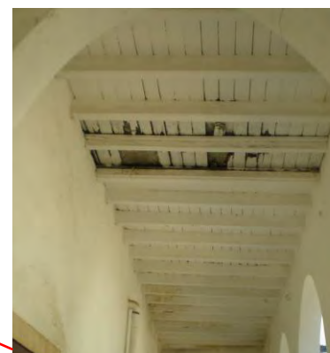
Plancher en solives du portique d'entrée.
