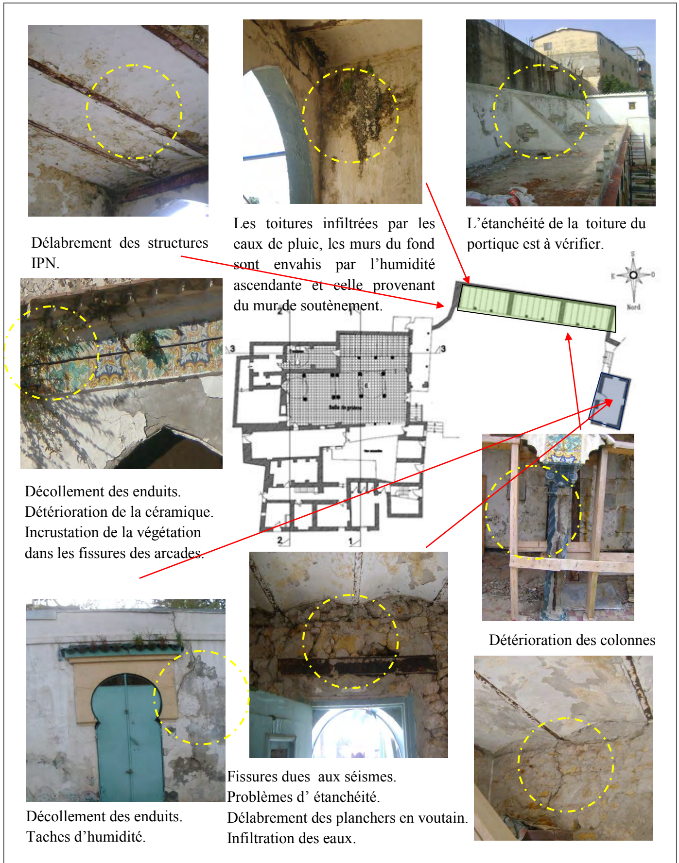
Figure 9: Diagnostic des dépendances de la mosquée de la zaouïa de Sidi M'Hamed.
