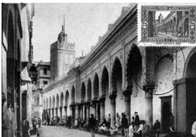
Figure 10 : Façade de la grande mosquée d'Alger.
