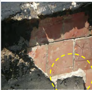
L'étanchéité actuelle de la mosquée en pax-aluminium dénatura complètement le monument
