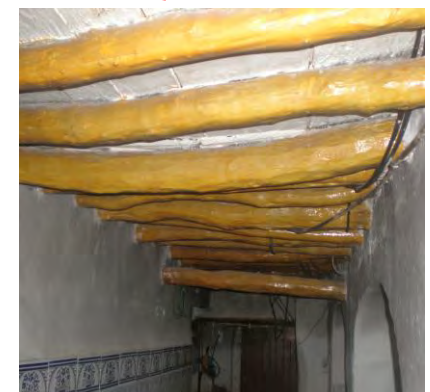
Les planchers de la galerie latérale de la salle de prière ainsi que le passage vers les locaux sont en rondins de thuya.
