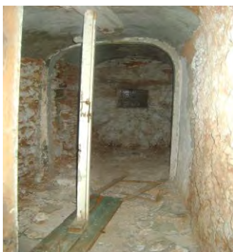
Murs de la kheloua en moellons.
