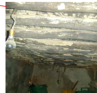
Les planchers de la galerie latérale de la salle de prière ainsi que le passage vers les locaux sont en rondins de thuya.
