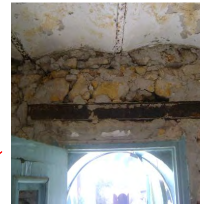
Le plancher de la maksoura est un plancher en voutains et profilés métalliques.
