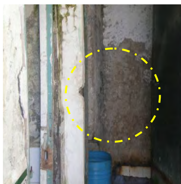
Taches d'humidité et décollement des enduits.
