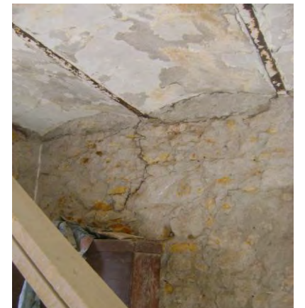
Le plancher de la maksoura est un plancher en voutains et profilés métalliques.
