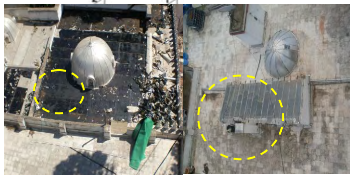
L'étanchéité actuelle de la mosquée en pax-aluminium dénatura complètement le monument
