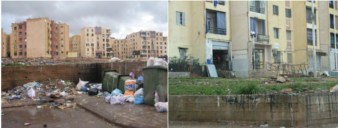
Photo 4 : La dégradation du cadre bâti au niveau de l'unité de voisinage N°8
