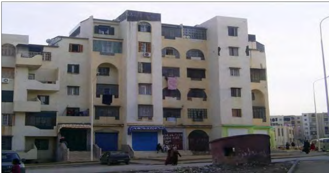
Photo 1 : logements Sociaux Locatifs à l'UV06 Constantine- Nouvelle Ville Ali Mendjeli.
