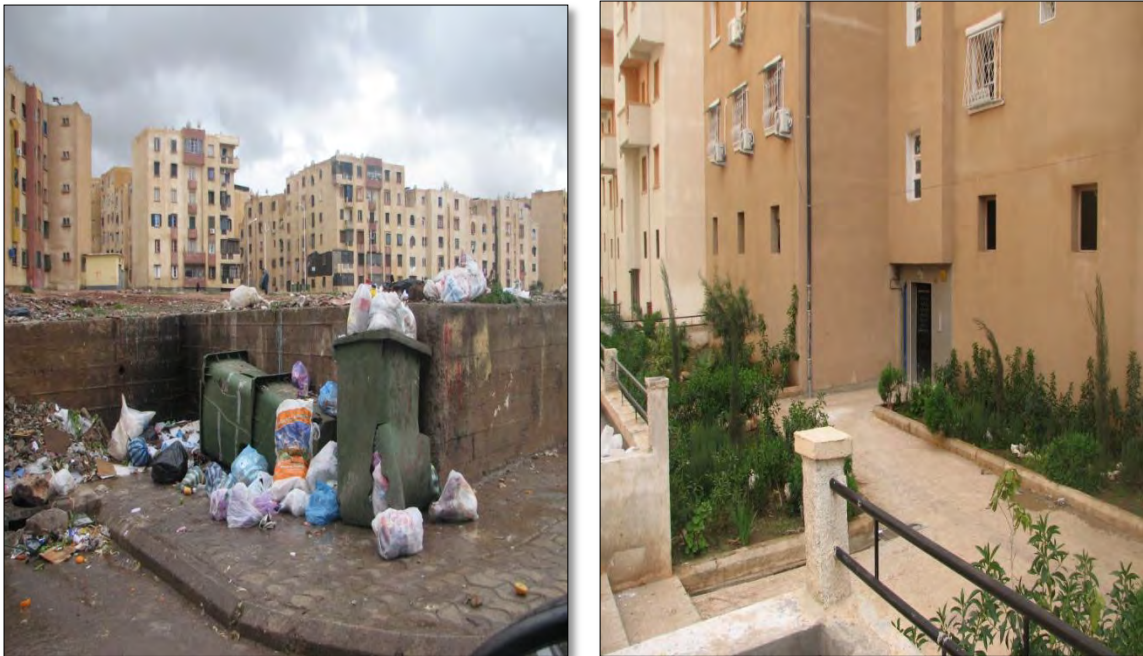
Photo 20 : L'état des espaces intermédiaires au niveau de l'UV8 et l'UV5 extension-1-
