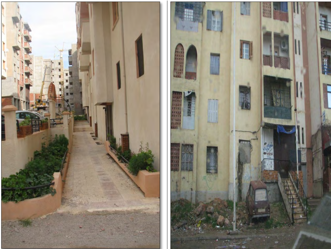
Photo 22 : l'état du quartier New York (UV8) et UV5 extension
