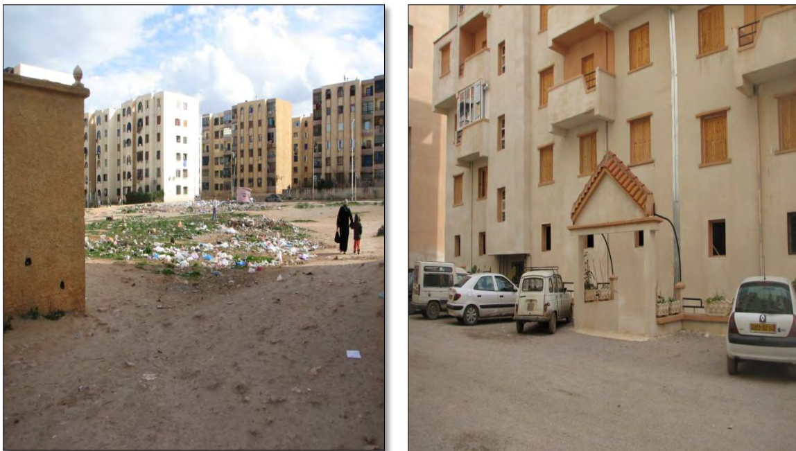
Photo 21 : L'état des espaces intermédiaires au niveau de l'UV8 et l'UV5 extension-2-
