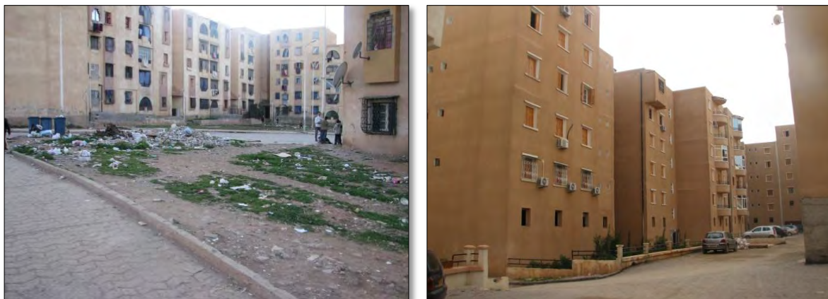
Photo 11 : les espaces intermédiaires au niveau de l'UV8 et l'UV5 extension
