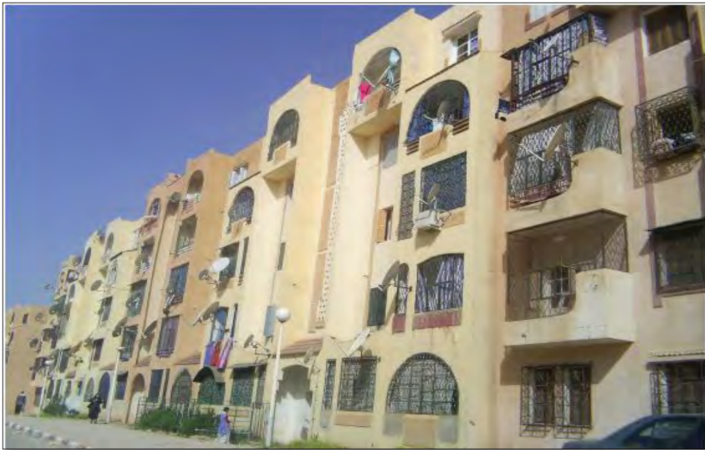
Photo 2 : logements Sociaux Locatifs à l'UV08 Constantine- Nouvelle Ville Ali Mendjeli.
