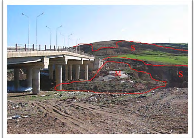
Photo 68 : Dégradation de la culée rive droite du pont de franchissement du Rhumel
