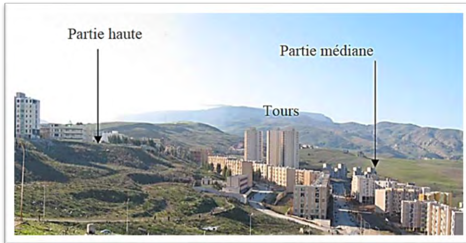
Photo 57 : Vue d'ensemble du site de Boussouf - talweg Ouest (2005). La Structure moutonnée des versants à gauche de la photo et derrière les immeubles est un signe clair d'instabilité. Source : DUC ; 2005.
