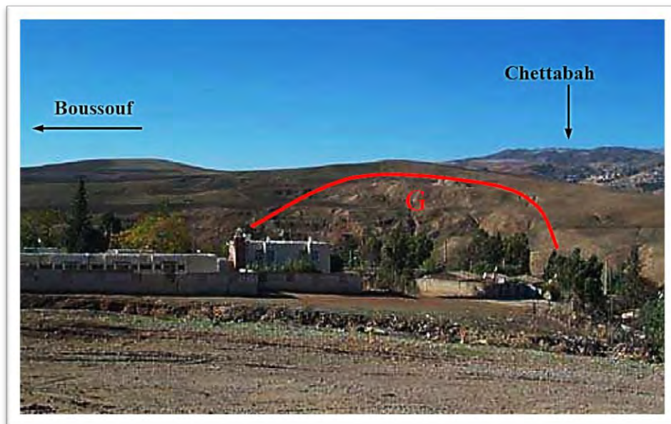
Photo 50 : Talus marneux de faible stabilité, en rive droite de Chaabet el Merdja.
