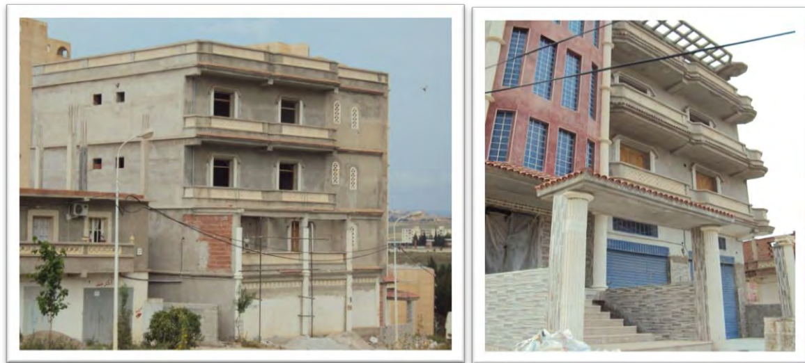
Photo : La construction individuelle dans la cité Naadja Sghira. Source : Auteur ; 2011.
