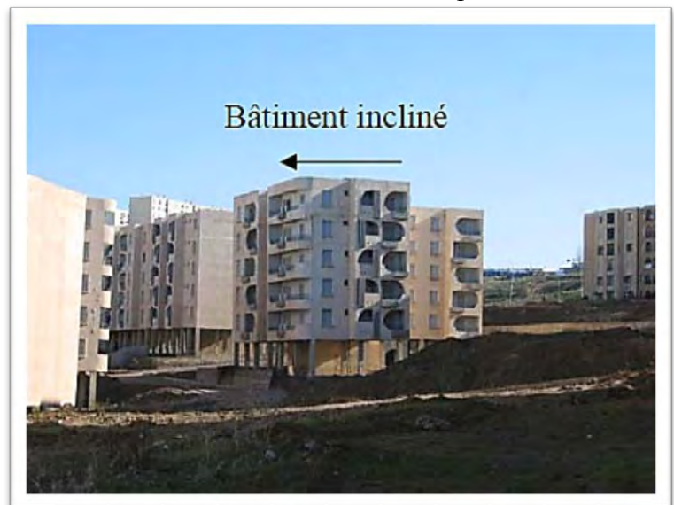
Photo 65 : Immeuble incliné de la cité CNEP. Source : DUC.
