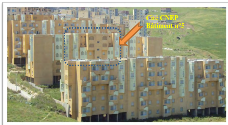
Photo 81 : Bâtiment n°5 dans la cité CNEP 128 Logements. Source : Auteur ; 2011.
