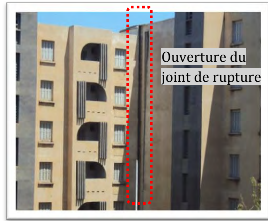
Photo 75 : Ecartement entre les deux blocs 4 et 5- ouverture du joint 60cm. Source : Auteur ; 2011.
