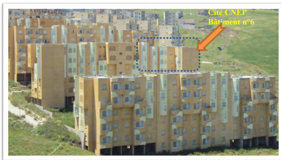
Photo 83 : Bâtiment n°6 dans la cité CNEP 128 Logements. Source : Auteur ; 2011.
