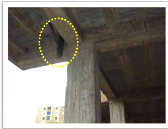
Photo 76 : Absence des descentes pour les différents réseaux d'assainissement. Source : Auteur ; 2011.
