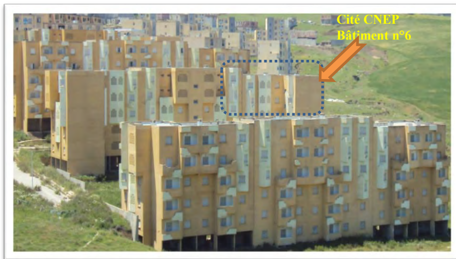
Photo : Bâtiment n°6 dans la cité CNEP 128 Logements. Source : Auteur ; 2011.
