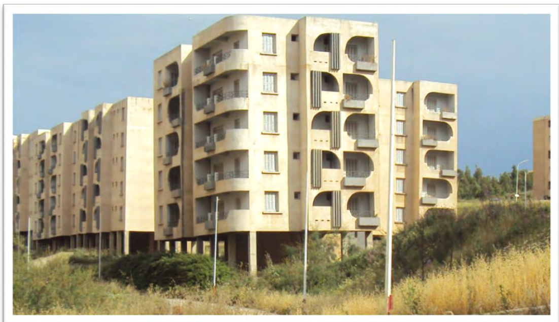
Photo 77 : Basculement du bloc 5. Source : Auteur ; 2011.
