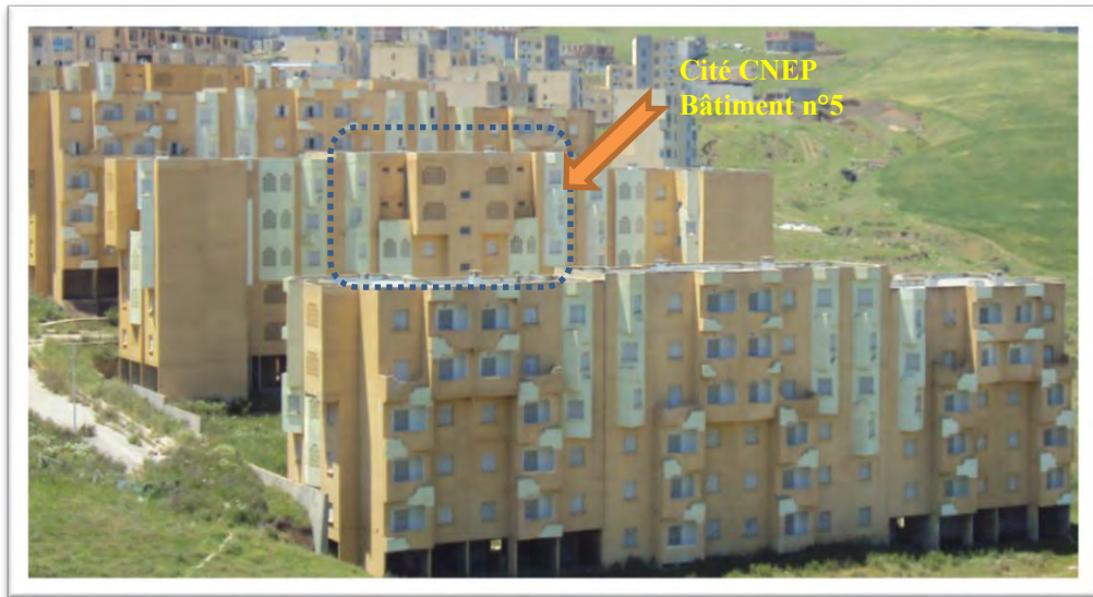
Photo : Bâtiment n°5 dans la cité CNEP 128 Logements. Source : Auteur ; 2011.
