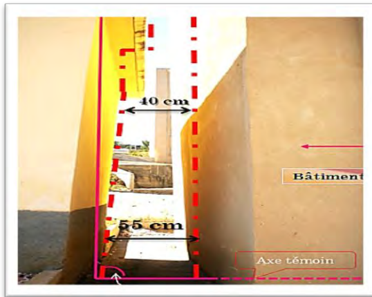
Photo 34 : Le basculement entre deux blocs de la « cité CNEP » Boussouf. Source: auteur2011
