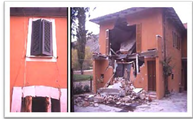
Photo 38 : Les fissurations dans les ouvertures en forme X. Source : .Garcia Jean-françois.2007.
