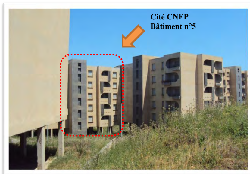
Photo 74 : Bâtiment n°5 dans la cité CNEP 150 Logements. Source : Auteur ; 2011.
