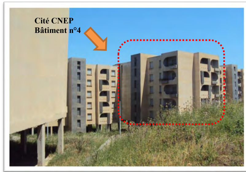
Photo : Bâtiment n°4 dans la cité CNEP 150 Logements. Source : Auteur ; 2011.
