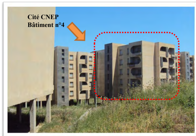
Photo 70 : Bâtiment n°4 dans la cité CNEP 150 Logements. Source : Auteur ; 2011.
