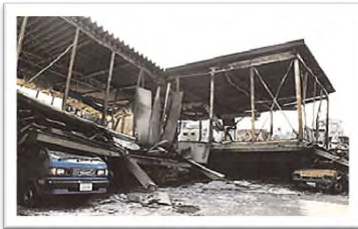
Photo 18 : Effondrement d'un bâtiment dont le rez-de-chaussée n'était pas suffisamment contreventé (séisme de Kobé, Japon, 17 janvier 1995). Source: Milan ZACEK ,2004.
