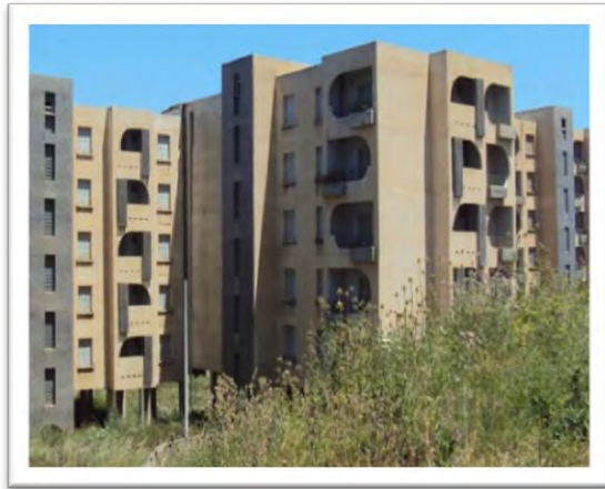
Photo 75 : Ecartement entre les deux blocs 4 et 5- ouverture du joint 60cm. Source : Auteur ; 2011.
