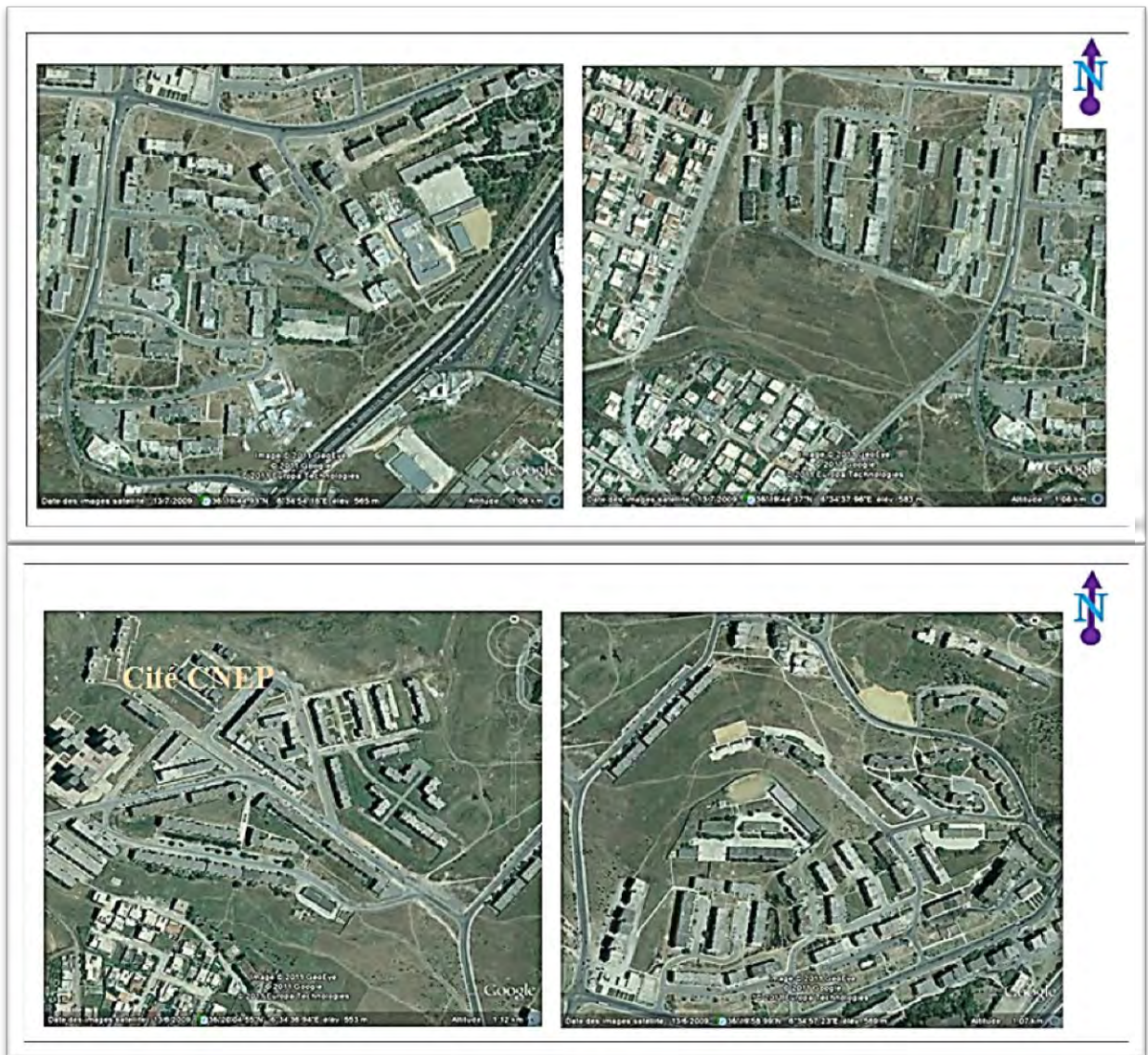
Figure 50 : Des vues aériennes sur le tissu collectif à Boussouf. Source : Google earth ;2011.
