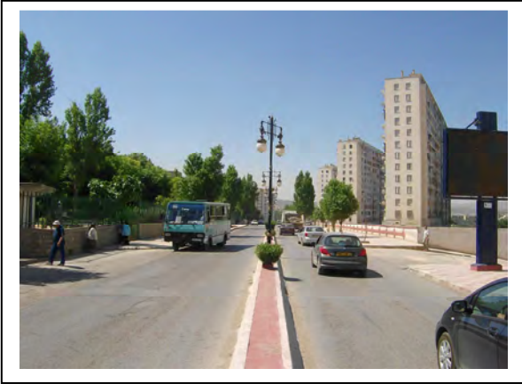
Photo N°48 : La séparation entre les deux voies de l'avenue Boumedous est insuffisante pour la sécurité du piéton qui la traverse.
