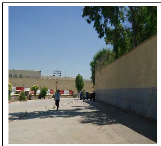
Photo N°18 : Le revêtement du trottoir et le mur de la caserne est en mauvais état, il n'améliore pas la qualité de l'espace traversé.
