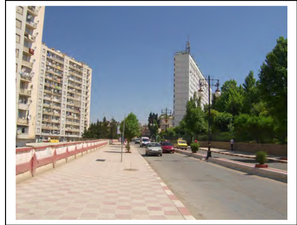
Photo N°49 : Un manque considérable de mobilier urbain et les trottoirs sont d'une mauvaise qualité de pavage.
