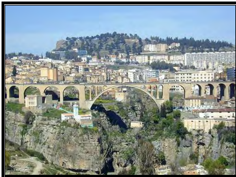
Photo N°07: le Pont Sidi Rached
