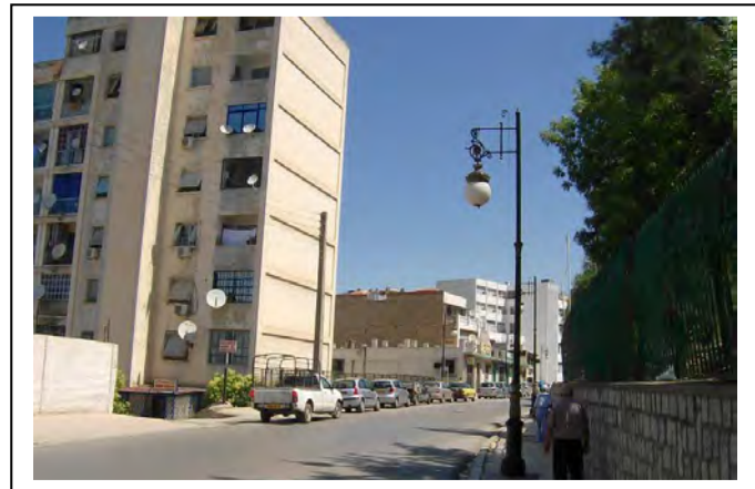
Photo N°39 : les trottoirs sont dans un état de dégradation.
