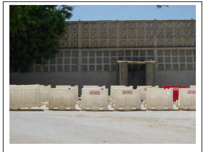
Photo N°20 : Le mur du stade ne correspond pas à une façade typique d'une enceinte sportive.
