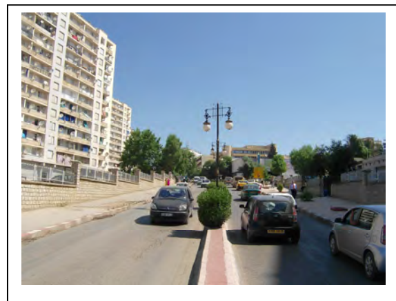
Photo N°54 : La séparation entre les deux voies de circulation mécanique est insuffisante pour la sécurité du piéton qui la traverse.
