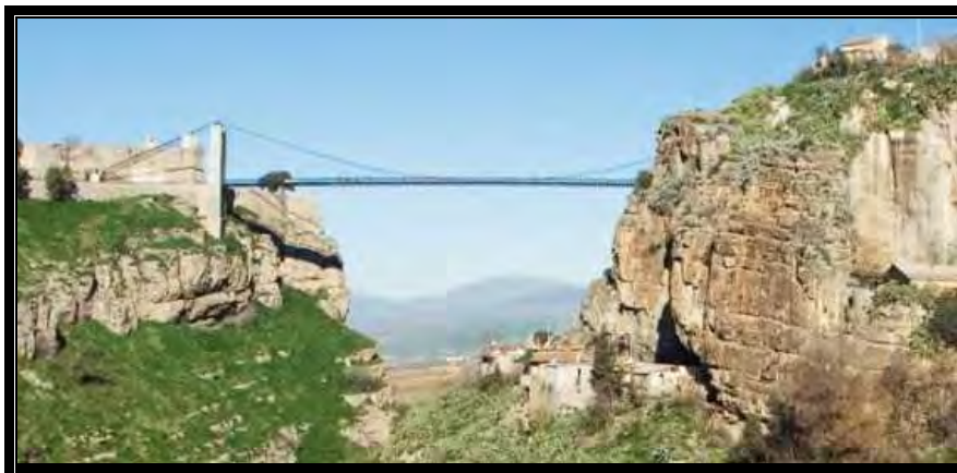
Photo N°05: le pont de sidi M'cid à Constantine
