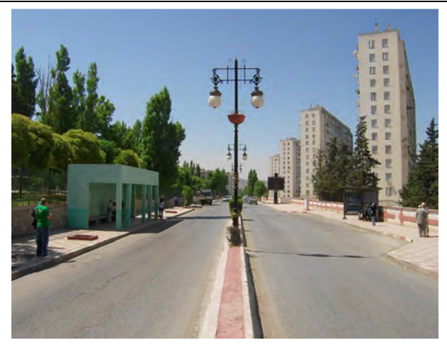
Photo N°47 : La station de bus empiète sur le trottoir, lequel est en principe réservé en principe à la circulation piétonne.
