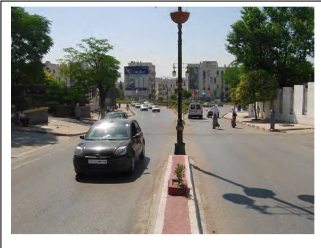
Photo N°56 : La séparation entre les deux voies de circulation mécanique est insuffisante pour la sécurité du piéton qui la traverse.
