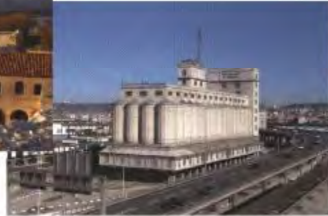
Le silo d'Arenc, future salle de spectacle et de bureaux
