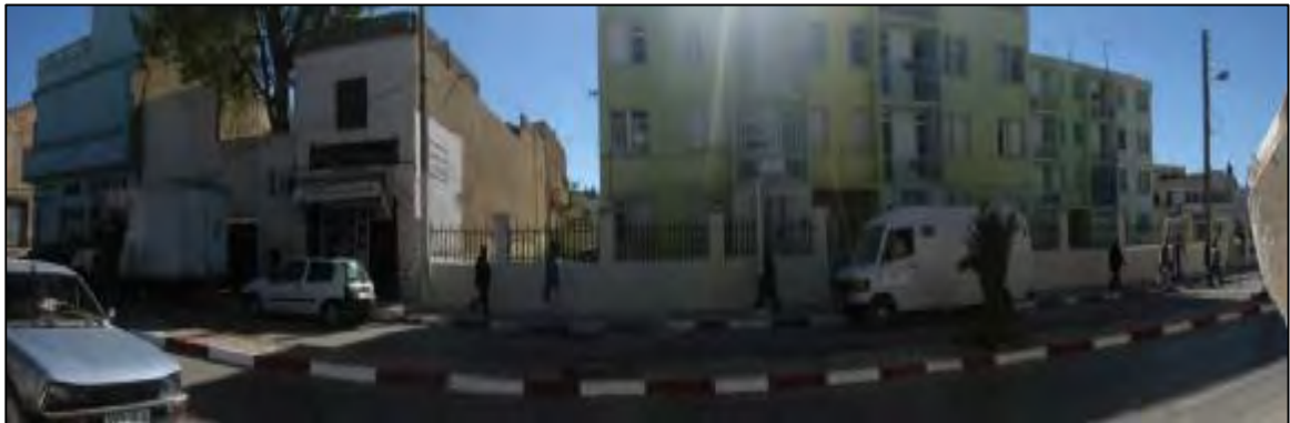
Continuité urbaine caractérisée par la dégradation du cadre bâti
