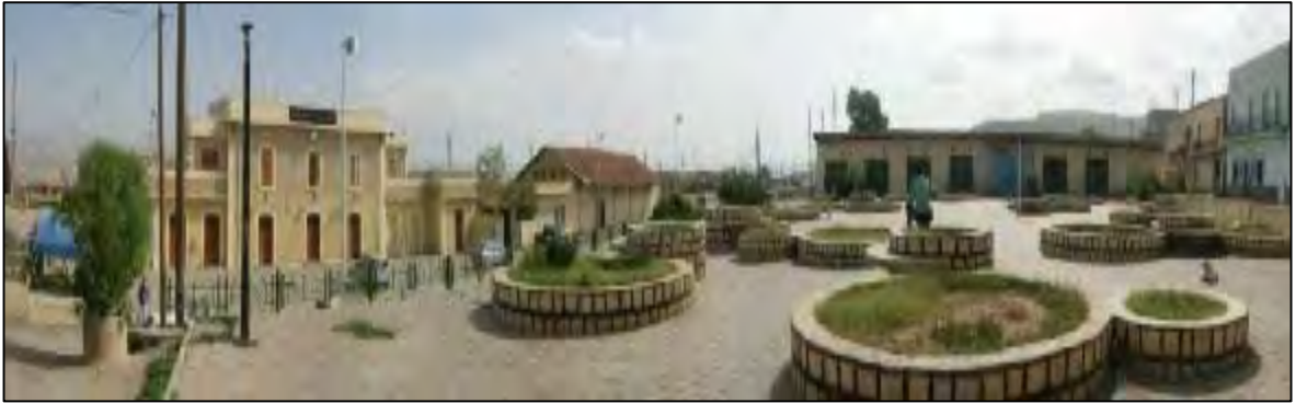
Photo n° 37: vue sur la placette de la gare.
