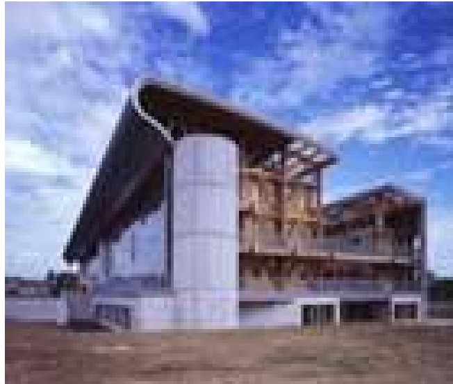
Fig 2.5: Système de toiture parasol. Projet Collège Guy Dolmaire, Mirecourt Source : K.Y. Liu et A. Baskaran ; 2005
