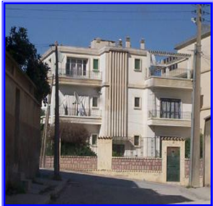
Photo n° 12: hauteur d'une construction R+2
