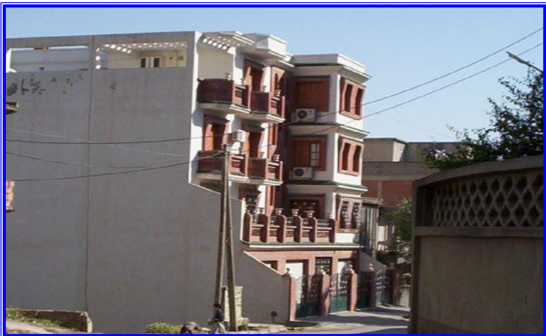
Photo n°09 : une construction de R+4
