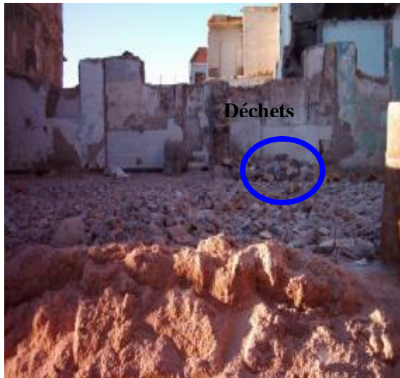
Immeuble d'habitation vétuste démolie (2004)
