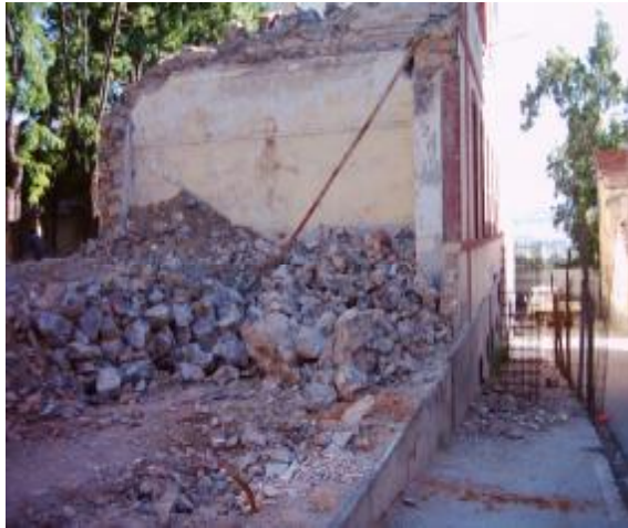
École primaire démolie (2004) (ACHERAD.S, 2004)
