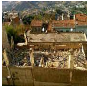
Glissement de terrain
