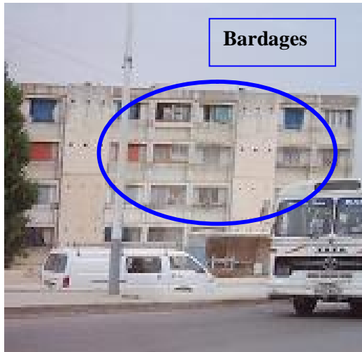
Façade d'un immeuble d'habitation collectif fermée avec des bardages
