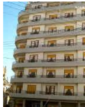
Cet immeuble a été démol.
