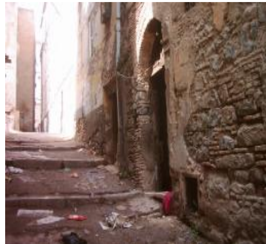
Vétusté du cadre bâti ancien
