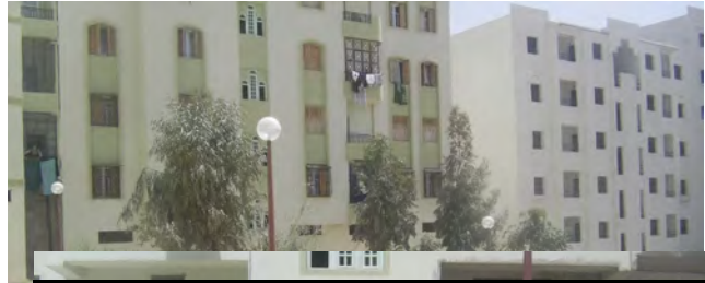
Photo N°32 : L'accès au bâtiment. 35 logements sociaux participatifs À l'UV 05 - Programme 2000. Constantine- Nouvelle Ville Ali Mendjeli.
