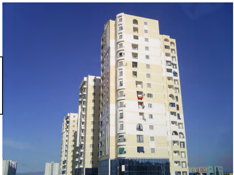
Photo N° 21 : Façade latérale d'un immeuble faisant parti des 1288 logements location- vente À l'UV 01 - Programme 2001. Constantine- Nouvelle Ville Ali Mendjeli. Source : L'auteur
