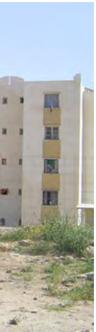
Photo N° 14 : Façades arrières des immeubles des 50 logements sociaux locatifs À l'UV 01 – Programme 2000.Constantine-Nouvelle Ville Ali Mendjeli.
