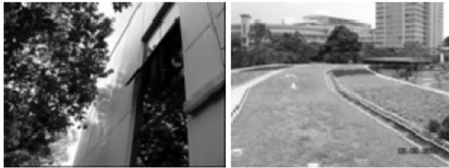
FIG.IV.29 : Mesures sur façade ouest et sur le toit (Gauche : façade à l'ombre ; droite : jardin sur le toit).
