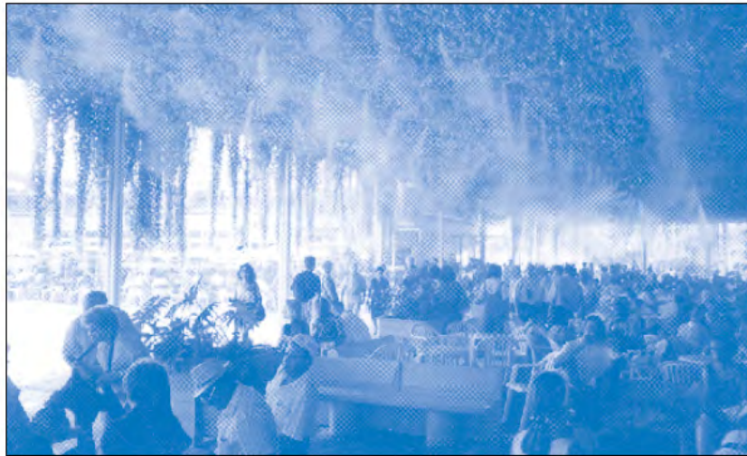
FIG.V.16 : Humidification utilisés à Séville (Pavillon de la CE).
