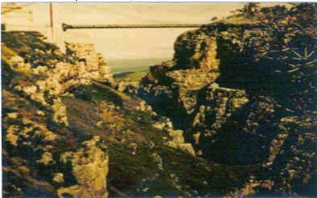
Photo n°58. Vue du pont Sidi M'cid, 1912
