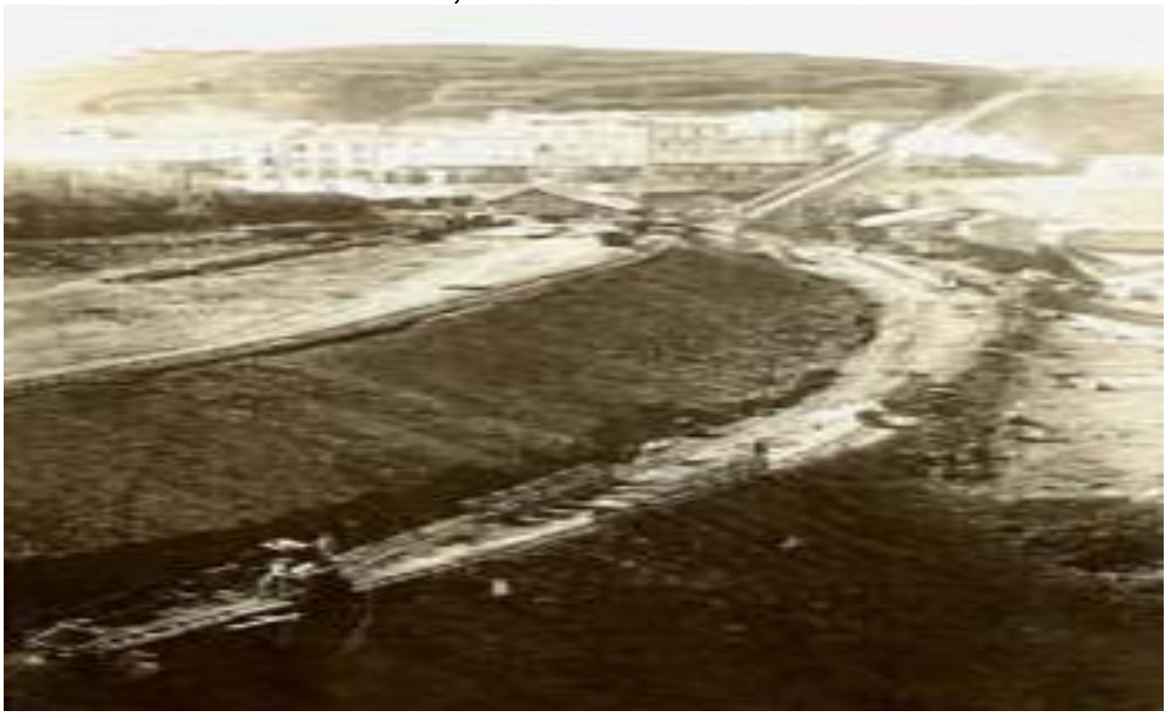
Photo n° 29. Travaux de déblais, 1899
