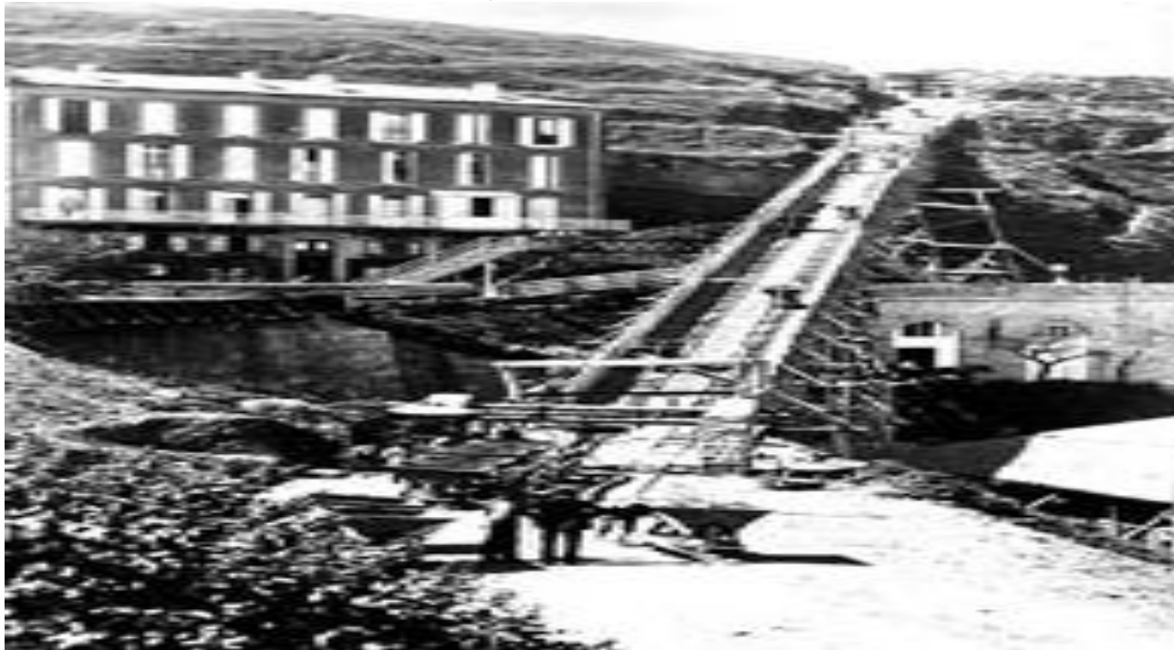
Photo n°30. Evacuation de déblais, 1899
