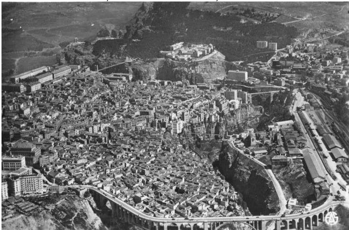
Photo n°47. Vue aérienne, délimitation de la médina, 1920
