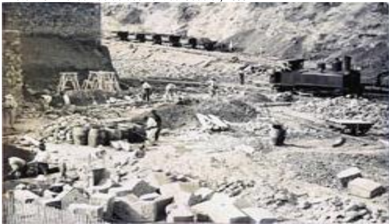
Photo n°31. Travaux de dérasement du Coudiat, 1899
