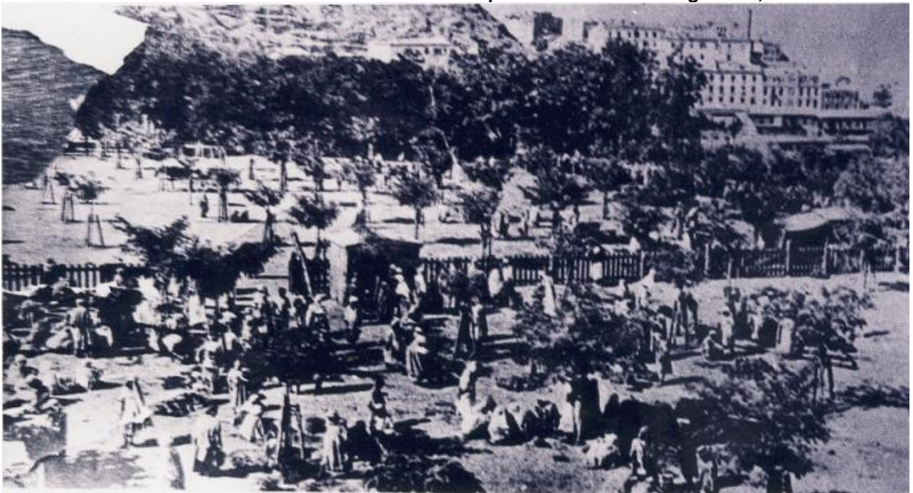
Photo n°25 : Vue sur la rue de Bienfait à droite et le plateau du Coudiat à gauche, 1900
