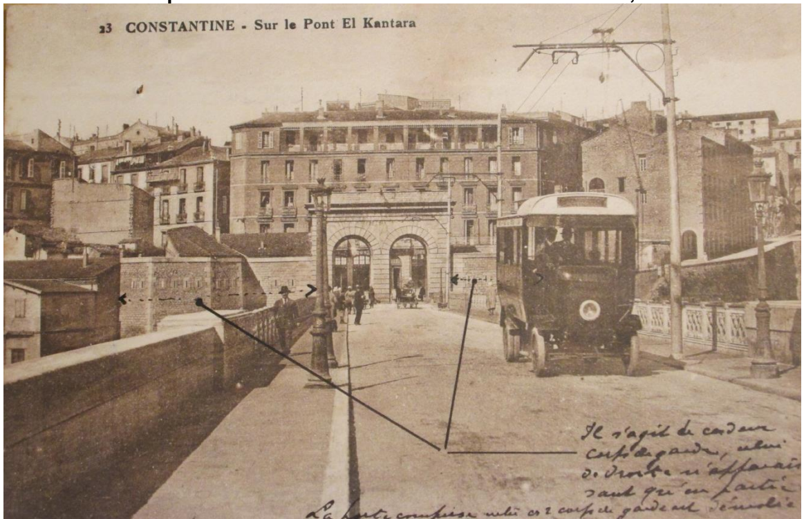
Photo n°61 : le pont d'El Kantara : entrée de la rue Nationale, 1874
