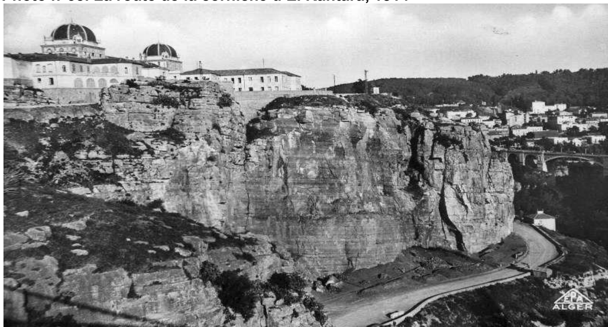
Photo n°38. La route de la corniche d'El Kantara, 1914
