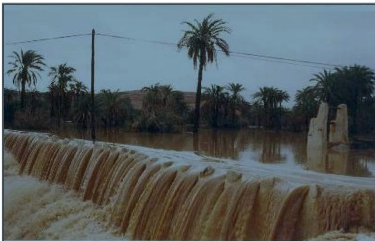
Fig.5: Barrage traditionnel, Ahbas, en crue (2008), photo Google
