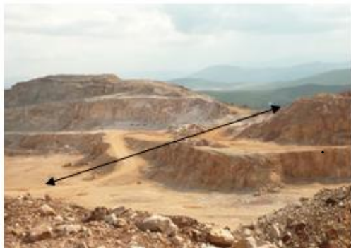
Photo-IX.5a -Vue vers l' OSO avec situation du couloir de faille
