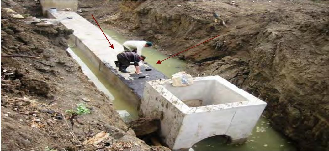
شكل رقم (79) إنجاز قنوات ربط المياه القدرة للتخفيف من حدة التلوث بواد بومرزوق
