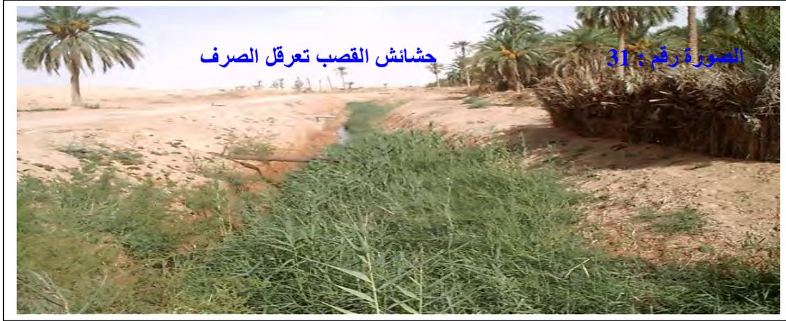
ما توضحه هذه الصورة هو نمو حشائش القصب بمقطع القناة مسببة في ذلك عرقلة الصرف الجيد للمياه و حتى لا تنمو هذه النباتات يجب أن تزيد سرعة المياه عن 0,5 م / ثا ويكون ذلك بخلق محطات رفع للمياه حتى نخلق ميلا يسمح للمياه بالانصراف نحو المصب، و تكون هذه المحطات وفق دراسة تقنية مسبقة .
