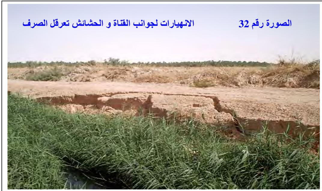
إن هذه الانهيارات التي غالبا ما نجدها على مستوى المنعطفات وأكواع القناة هي سبب و نتيجة لعرقلة المياه بمقطع القناة مما يرفع أيضا مستوى السماط السطحي الضار بالبيئة و النبات
