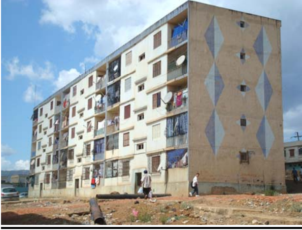
صورة رقم 36: سكن جماعي حسب صيغة البيع بالإيجار للصندوق الوطني للتوفير و الاحتياط - يقع بوسط مدينة تمالوس
