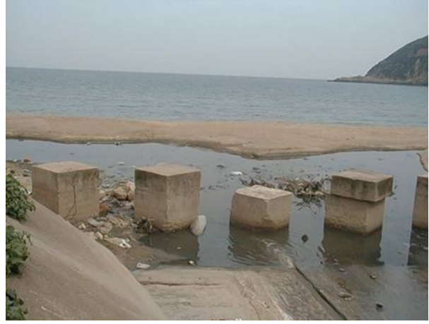
صورة رقم 31: مصب للمياه القذرة في أحد الشواطئ بوسط مدينة القل
