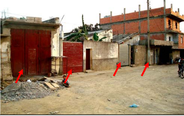
صورة رقم 76: تهيئة محلات تجارية في الكثير من المساكن بالقرية الفلاحية رامول بالقل
