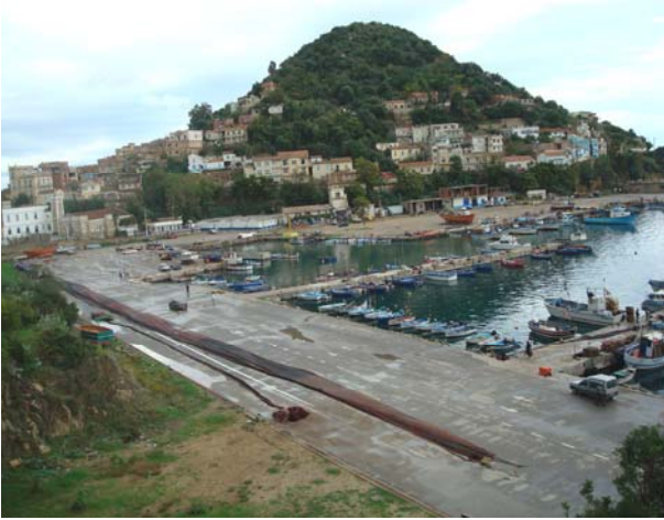
صورة رقم 07: ميناء القل بعد تهيئته و توسيعه في عهد الاستقلال (الثمانينات)
