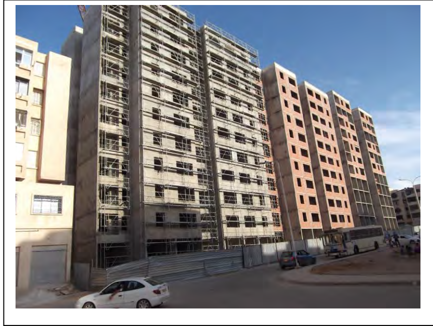
Photo : 138 La moitié des logements de la promotion Dembri transformée en tour de R+10
