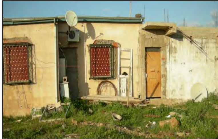
Photo VI. 13 : Toiture terrasse et fer d'attente à la place de la tuile
