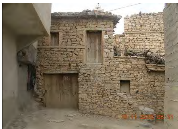
Photo III.5 & Photo III.6 : Association de 2 matériaux naturels et traditionnels, Toub et pierre, au Sud des Aurès,
