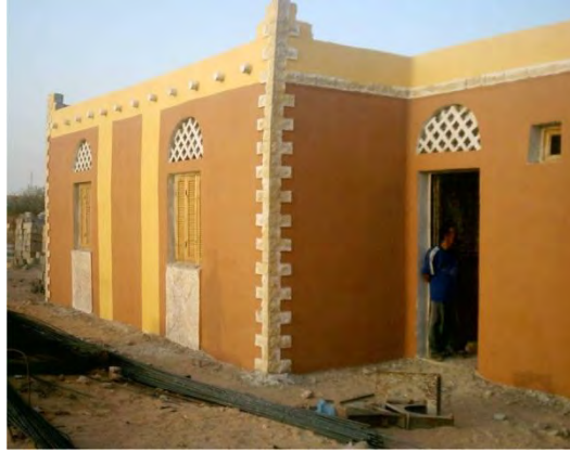
Photo III.24 : Rural à Tindouf modèle Saharien en groupé, Le traitement des façades, et couleurs sont assez différents.
