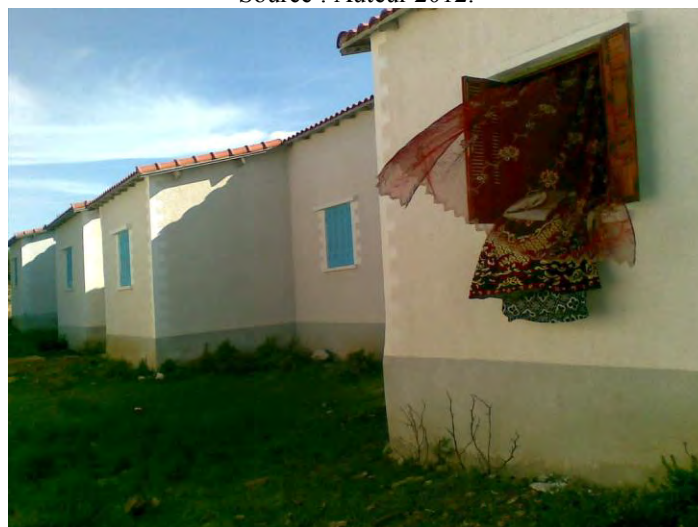
Photo VI. 24 : Ouvertures sur extérieur
