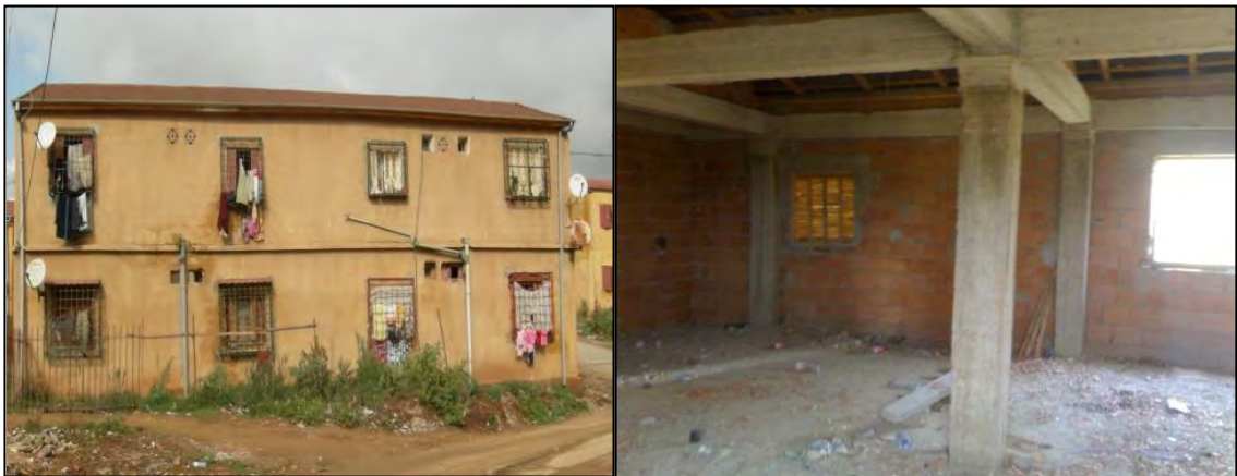
Photo. V. 7 & Photo. V. 8 : Les matériaux de construction utilisés
