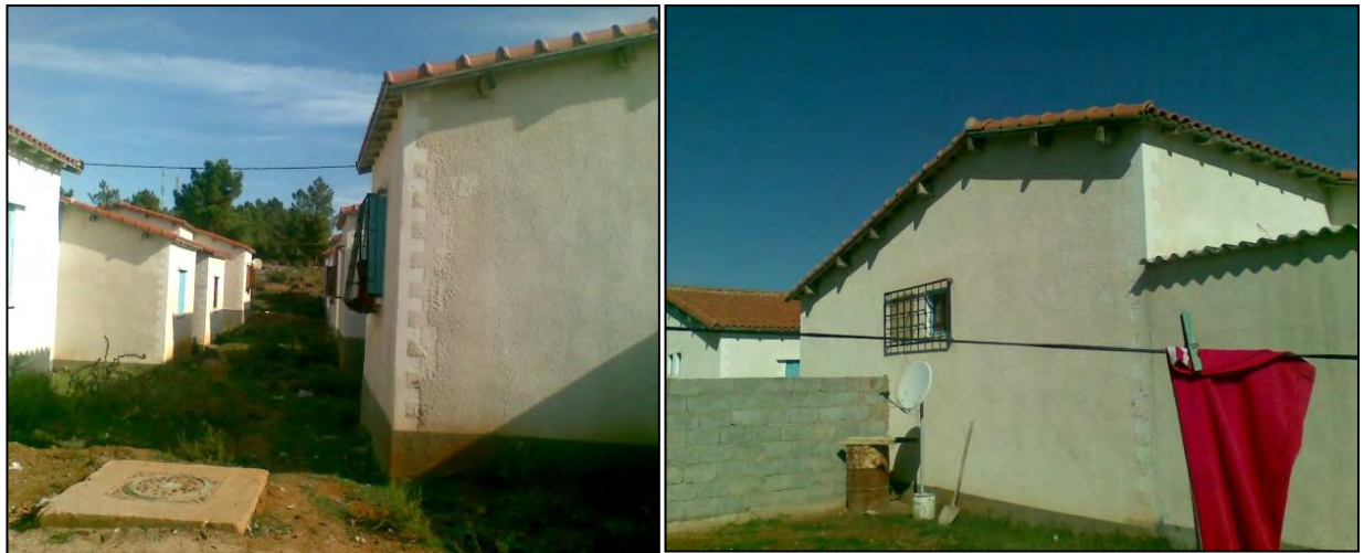
Photo VI. 14 & Photo VI. 15 : toiture en Tuile pour le semi-groupé / El Kala.
