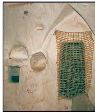
Photo II.43 : Niches arrondies percées directement dans les murs
