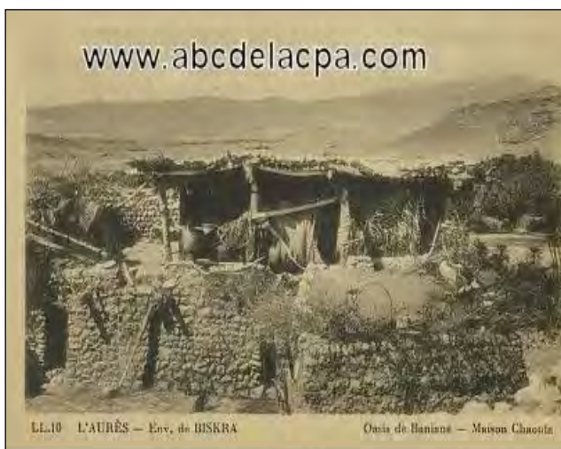
Photo III.8 & Photo III.9 : Ossature, Couverture et Revêtement extérieur.
