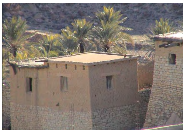
Photo III.5 & Photo III.6 : Association de 2 matériaux naturels et traditionnels, Toub et pierre, au Sud des Aurès,
