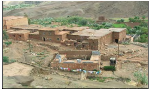
Photo II.32 : Maisons à toit en terrasse habitées par des berbères Chaouias
