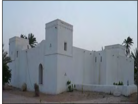
Photo II.36 : Vue sur l'extérieur
