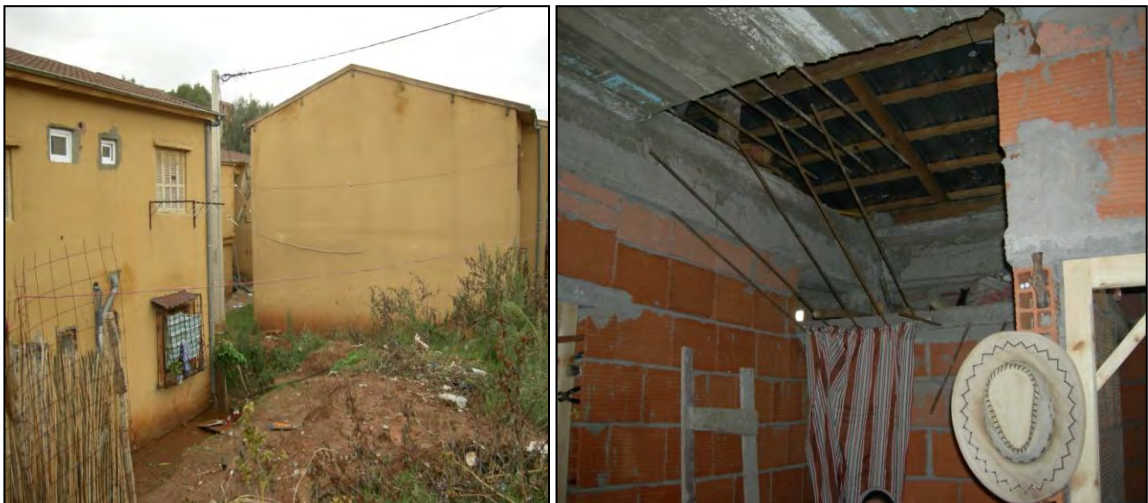
Photo VI. 11 & Photo VI. 12 : La tuile remplacée par une toiture plate
