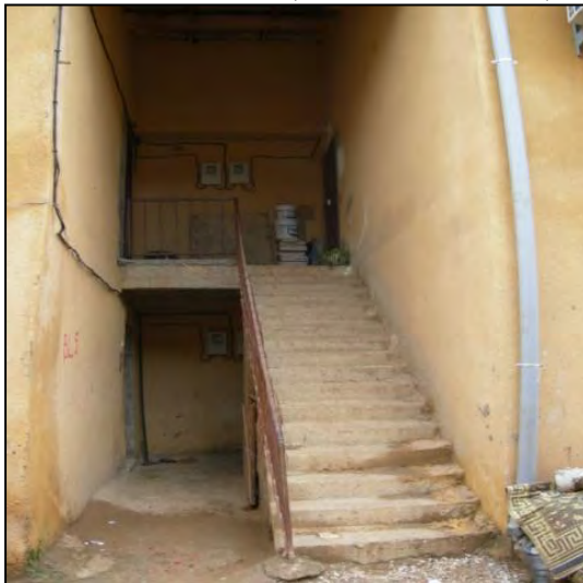
Photo. V. 9 : Cage d'escalier vue de l'extérieur
