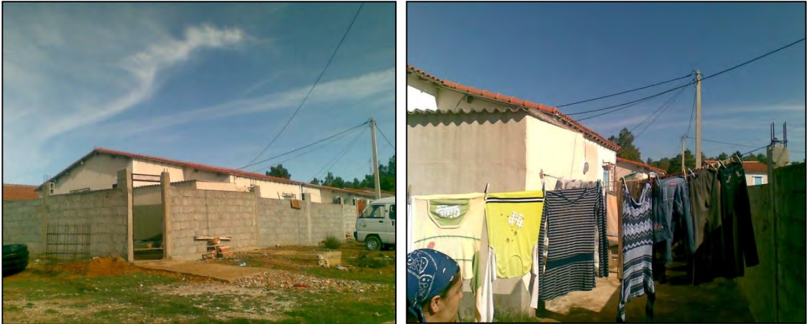
Photo VI.9 & Photo VI.10 : Clôture réalisée pour abriter la cour manquant au logt
