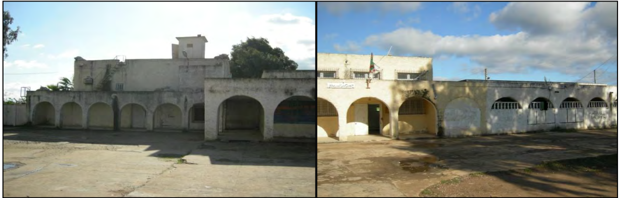
Photo. V. 27 & Photo. V. 28 : Équipements accompagnant le VSA (agence PTT, centre commerciale)
