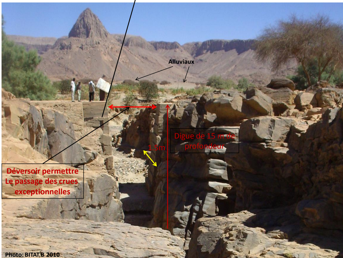
Photo n° 29 : Barrage en béton
