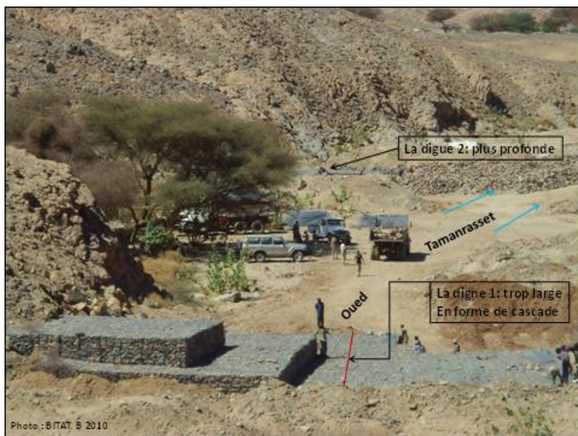
Photo n°27: La construction de deux barrages en gabions au Nord de la ville
