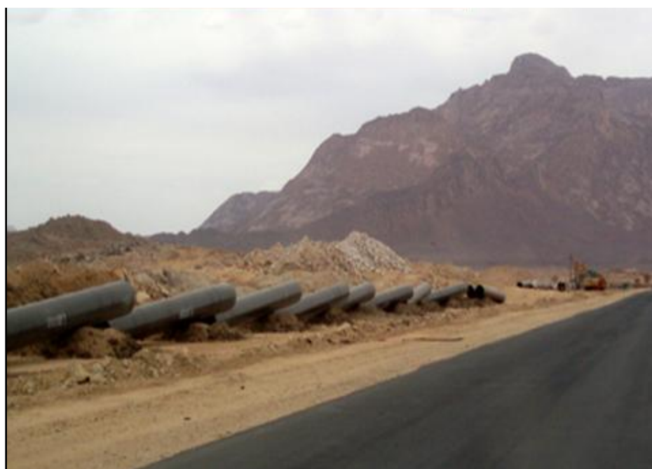
Photo n°50 : Conduite enterrée à 12 m de l'accotement de RN1
