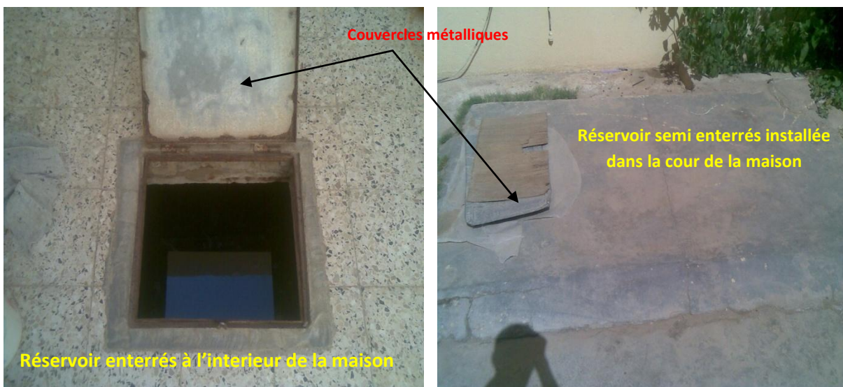
Photo n°45 : Réservoir enterré
