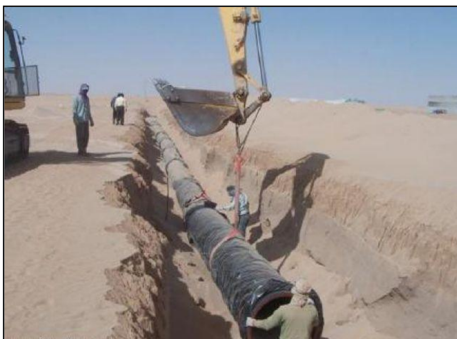
Photo n° 51: Conduite sur un seul linéaire en écoulement gravitaire
