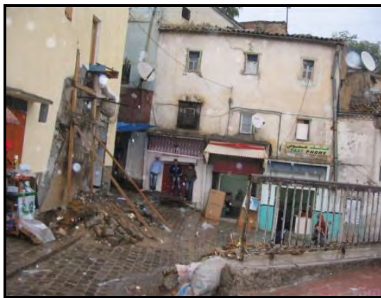
Photo 81: avant intervention. Source : Auteur 2008.
