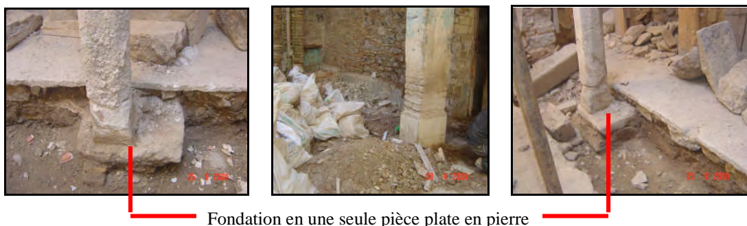
Fiche 11 : Fondation isolée en une seule pièce en pierre plate surfacée. Source : Chantier de réhabilitation de la maison 28. Auteur 2011.
