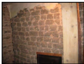
Fiche 17 : Mur construit en brique de terre cuite. Source : Chantier de réhabilitation de la maison 12. Souika. Auteur 2011.
