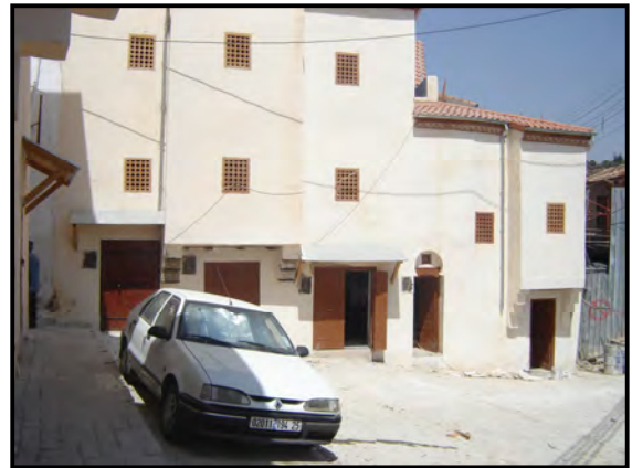
Photo 82 : après intervention. Source : Auteur 2010.
