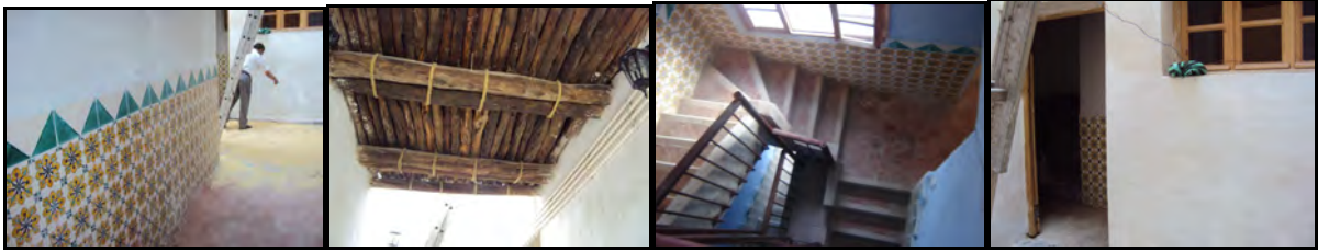
Photo 84 : Intérieur de la maison 12 pendant l'intervention. Source : Auteur.2010.
