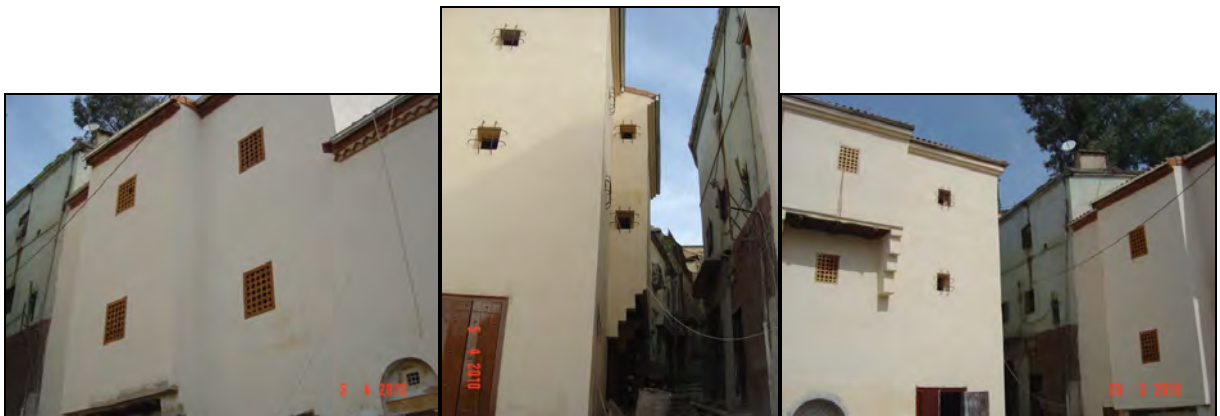
Photo 83 : après intervention. Source : Auteur 2010.
