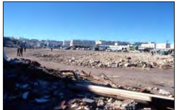
Photo 16 : insalubrité et désordre.
