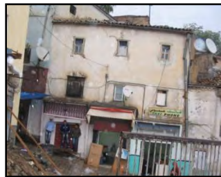
Photo 78 : Etat des lieux (maison 19).
