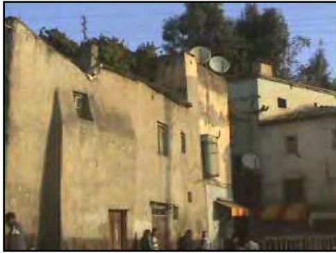
Photo 66 : avant intervention. Source : l'auteur, 2006
