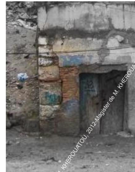
Figure 3-30 Sous bassement en gros appareil, r Benzegouta (auteur, 2007)
