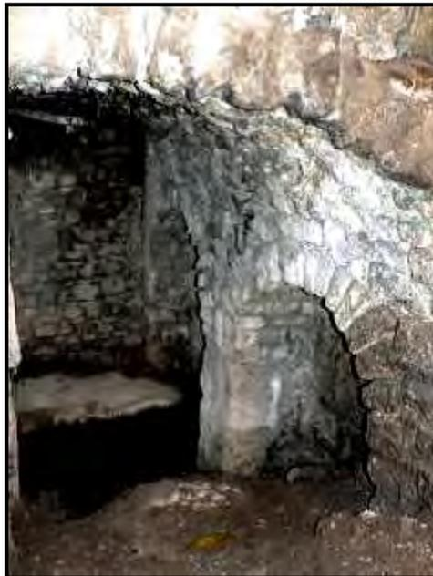
**Figure 2. 17 :** Même maison : la structure des soubassements est romaine constituée d'une série de deux voutes à claveaux de basses hauteurs. Source : A. Bouchareb, D.E, 2006.
