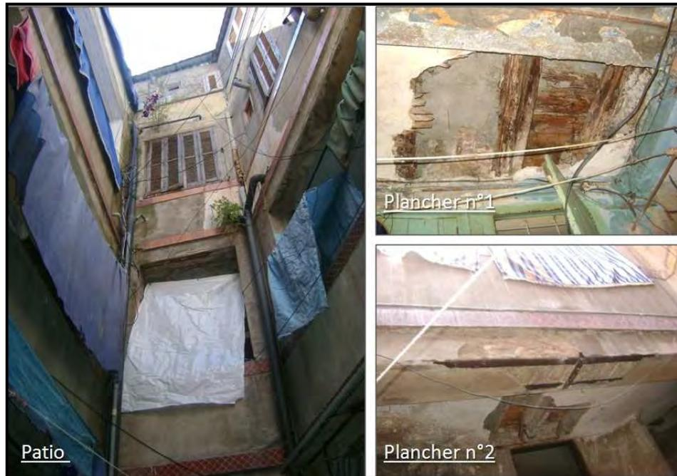
**Figure 2. 37** : Plancher traditionnel, composé de rondins en bois et de Thuya, renforcé avec du fer. Source : auteur, 2011.
