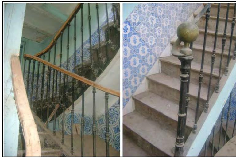
**Figure 2. 102 :** Escalier colonial "hélicoïdal" en bois et en fer forgé. Source : auteur, 2011.
