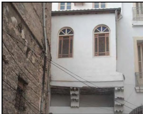
**Figure 2. 76** : Décrochement typique sur la façade principale. Source : auteur, 2011.
