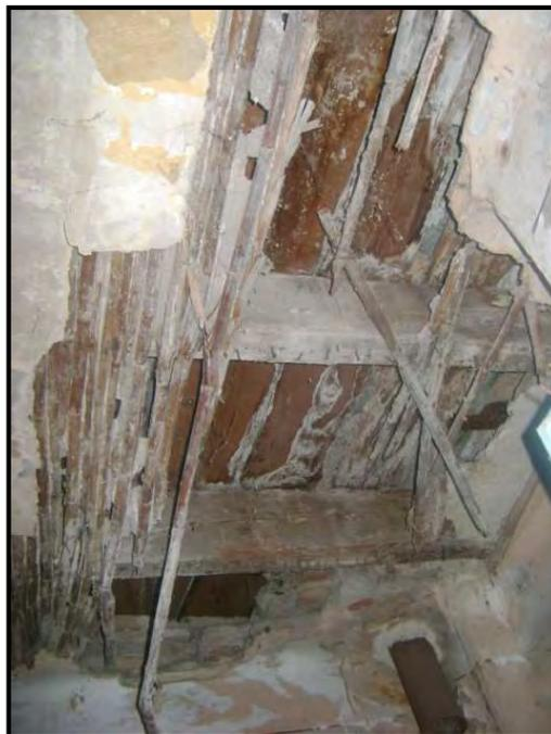
**Figure 2. 114 :** Maison Ingliz Bey : Plancher traditionnel en bois (au niveau du rez-de-chaussée). Source : auteur, 2011.
