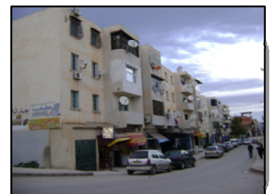
Photo n°11: Logement promotionnel collectif (cité 72 logements)
