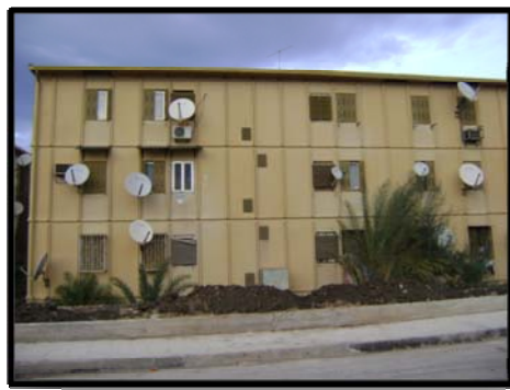
Photo n° 07: Logement social collectif en métal (cité 250 logements les frères Ferrad)
