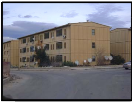
Photo n° 06: Logement social collectif en métal (cité 250 logements les frères Ferrad)
