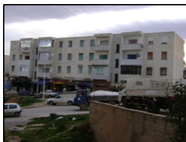
Photo n°10: Logement promotionnel collectif (cité 72 logements)
