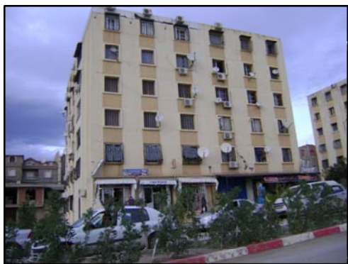
Photo n° 04: Cité Bouaamama 564 logements le type d'habitat socio collectif en dure
