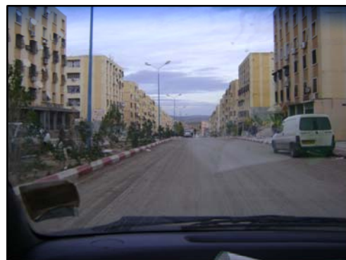
Photo n° 05: Cité Bouaamama 564 logements le type d'habitat socio collectif en dure
