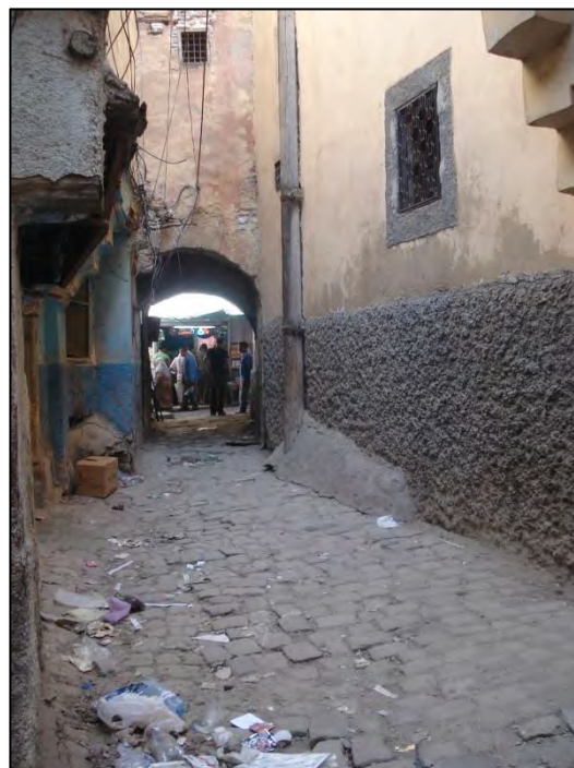
Ordonnement de façades dans la rue Bekhouche Abdeslam façades traditionnelles, K'bou, passage couvert...
