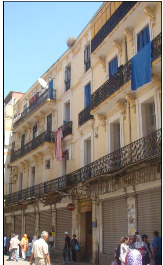
Alignement de façades coloniales dans la rue Larbi Ben M'hidi
