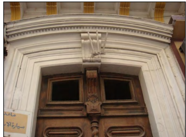
Éléments architectoniques de l'architecture coloniale, rue Larbi Ben M'hidi Encorbellement, corniche, porte avec imposte
