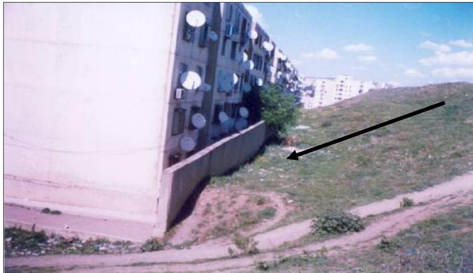
Photo n°24 : Un grand glissement menaçant directement un immeuble mur de soutènement inadapté aux personnes en présence sur le versant -Site de Boussouf-
