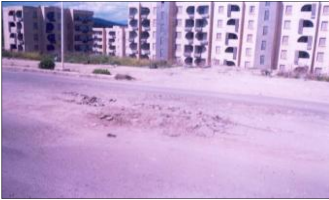
Photo n°17 : Bossellement du revêtement de la chaussée -Site de Boussouf-
