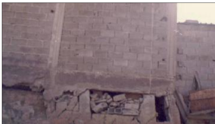
Photo n°9 : Rupture des armatures longitudinales du poteau et dégradation de la plate forme d'une construction au quatrième îlot
