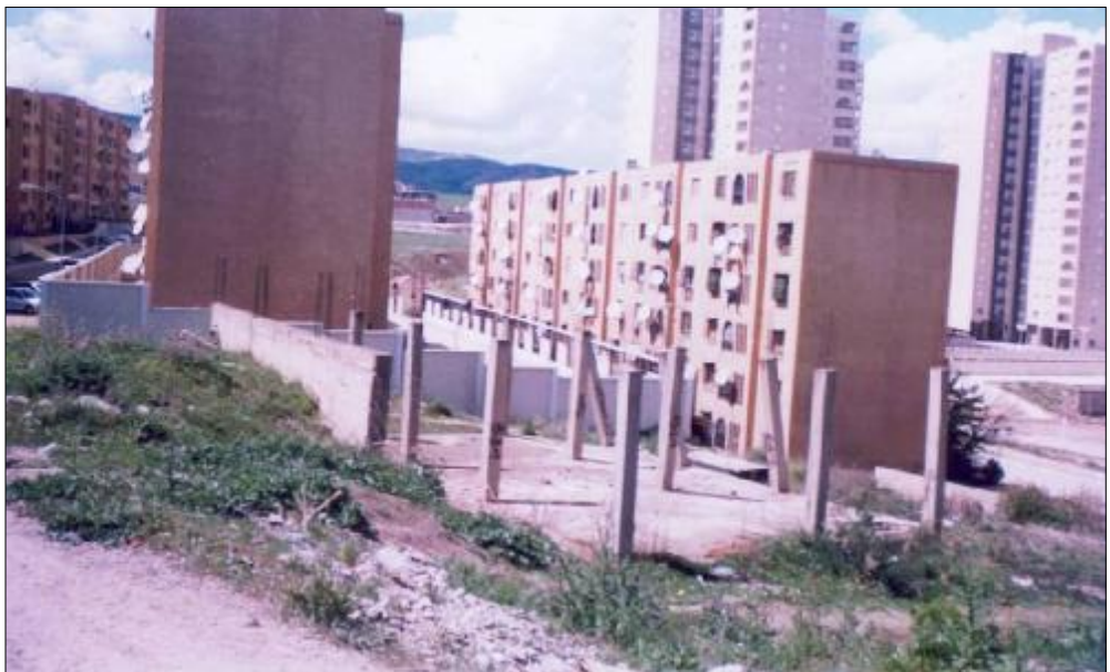
Photo n°12 : Suintement d'eau et fissuration sur un mur de clôture -Site de Boussouf-
