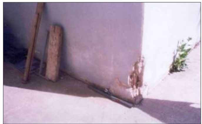
Photo n°18 : Rupture des armatures longitudinales d'un poteau de l'école Teniou -Site de Boussouf-
