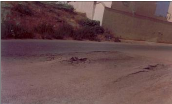
Photo n°19 : Bousselement et dégradation du revêtement de la chaussée près de l'école Azabi -Site de Boussouf-
