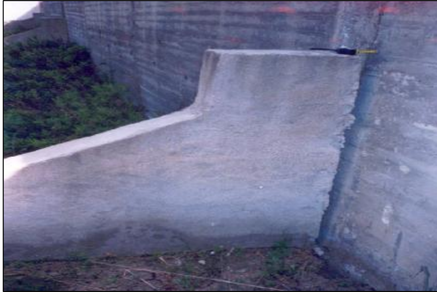
Photo n°15 : Déplacement d'un mur de soutènement à l'école Azabi - Site de Boussouf-
