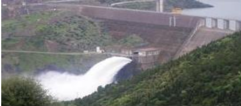
Photo 3 : Exemples de vidanges de fond des barrages de l'Est algérien (d'après l'ANBT, 2014).
