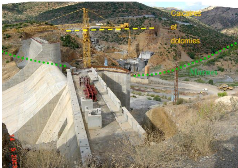
Figure 16 : Les fondations du barrage de Tichy Haf (Frossard, 2015)
