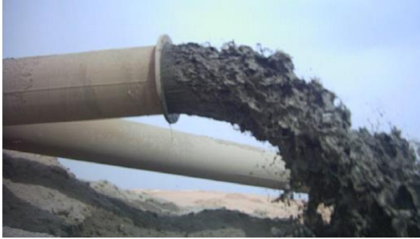
Photo 10 : Rejet de la vase lors de l'opération de dragage de 2005 (Rémini, 2018).
