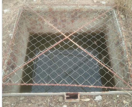
Photo 6 : Bac Colorado installé à proximité de la retenue du barrage de Zardezas ( ANB, 2018 )
