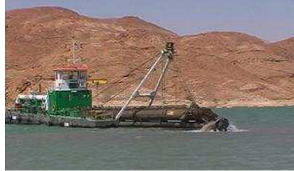
Photo 11 : Dragage suceuse/refouleuse en activité dans la retenue de Foug El Gherza (IME, 2010).
