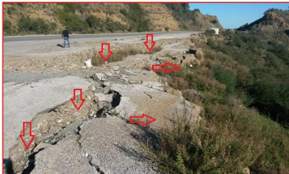
Photo29. Bassin versant de l'oued Lagreme : « glissement de terrain » le long de la route N°77
