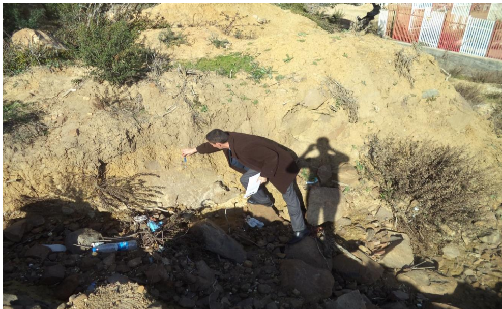
Photo20. Bassin versant d'oued Lagreme: Érosion active sur des terrains à substratum olistromique , El Ghariana
