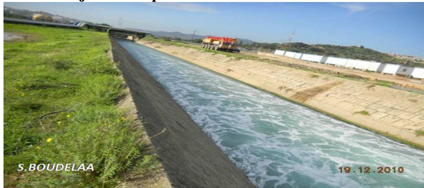
Canal de rejet du complexe GNL vers la mer
