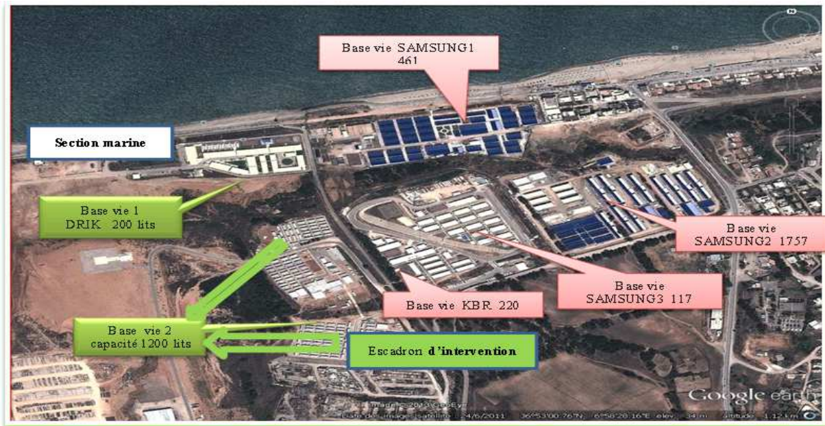
Fig 80 :Les bases de vie au niveau de la zone industrielle de Skikda
