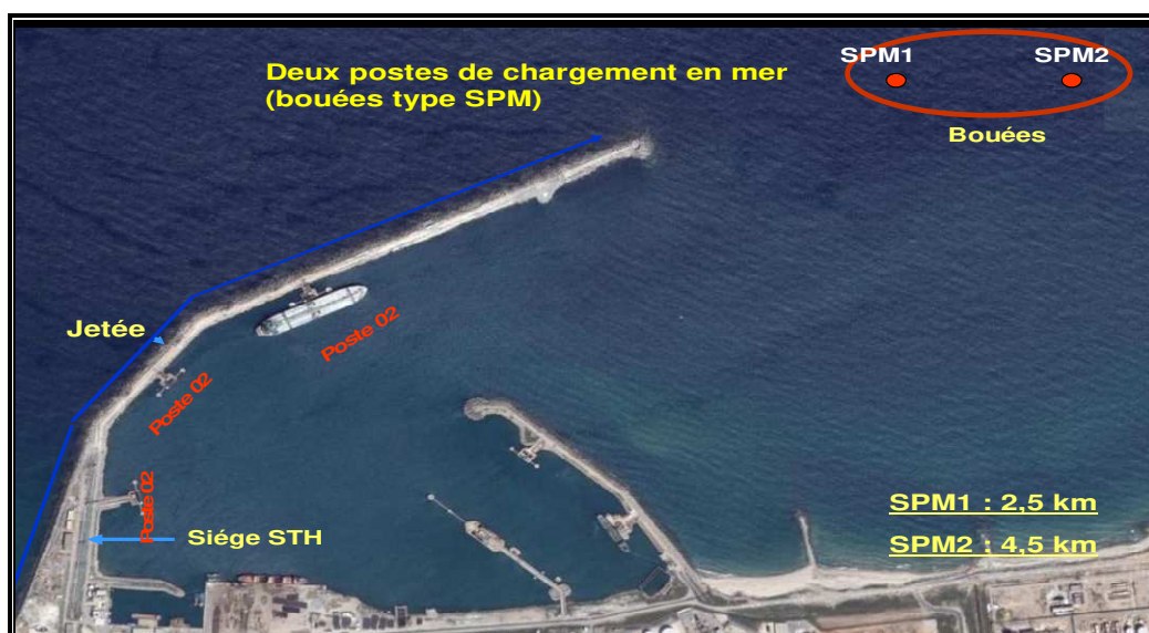
Fig 93 :Les deux postes flottants de chargement des hydrocarbures liquides à Skikda
