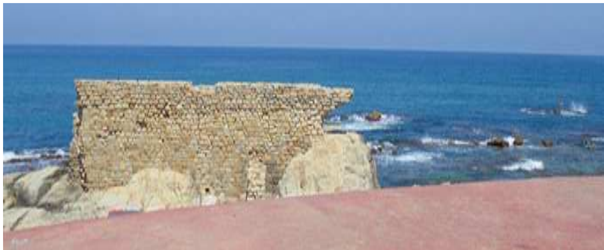
Fig 51: Un mur qui faisait partie de la ville détruite par le séisme d'août 1856 (la ville de Jijel)
