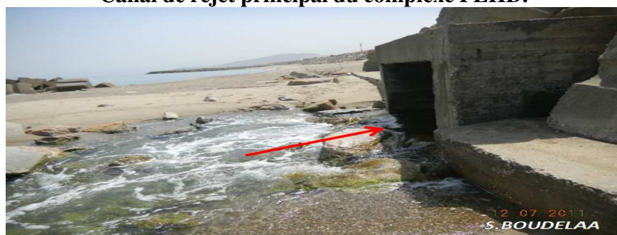
Canal de rejet des eaux usées de la raffinerie (canal Marhoum).
