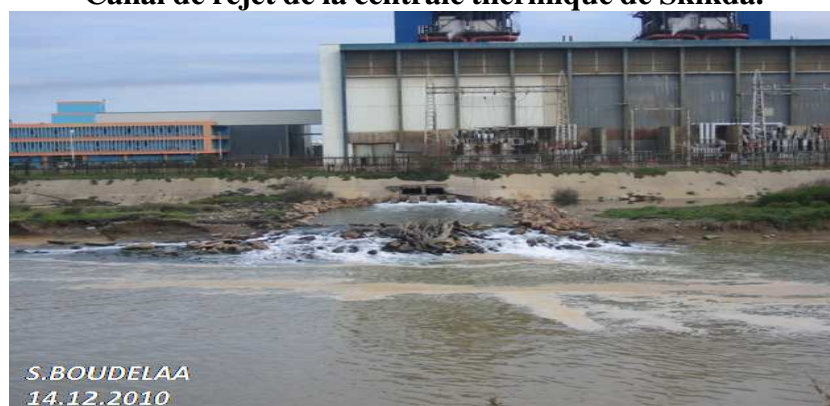
Canal de rejet de la centrale thermique de Skikda.
