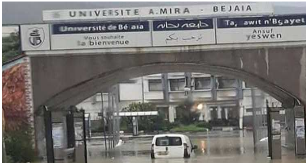
Fig. 55: Inondation à l'entrée de l'université de Béjaia (mars 2018)
