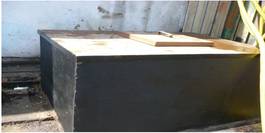
Fig 106 :Bac de rétention de huiles usagées (port Skikda)
