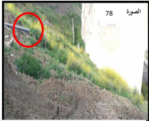
الصورة رقم 77،76،78،79 تمثل إشكالية الصرف الصحي وانزلاق التربة على التوالي مما تسبب في انشقاق وتدهور عمارات CNEP الحاذية لحي النعجة الصغيرة وبعض أساسات المنازل.
