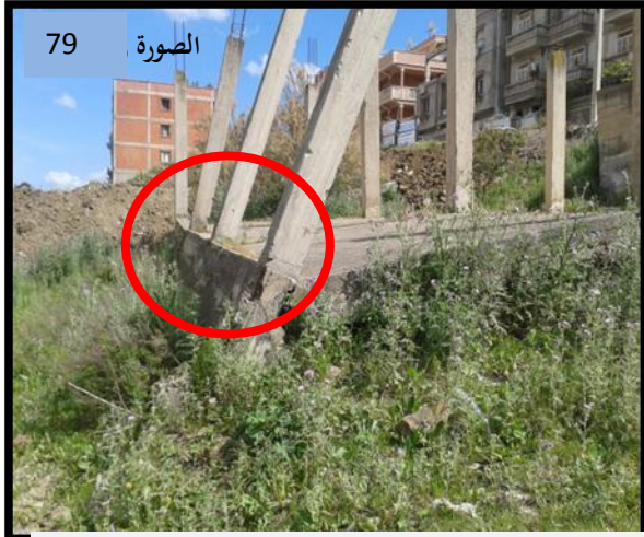
الصورة رقم 77،76،78،79 تمثل إشكالية الصرف الصحي وانزلاق التربة على التوالي مما تسبب في انشقاق وتدهور عمارات CNEP الحاذية لحي النعجة الصغيرة وبعض أساسات المنازل.
