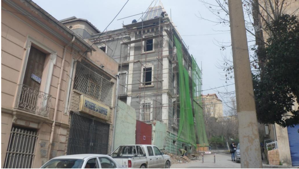
صورة رقم 11: عملية ترميم البنايات الأوربية (الباحث 2016)
