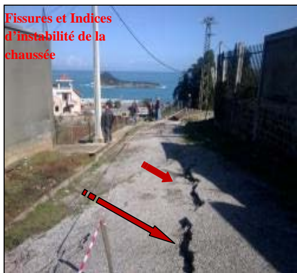
Photos.29,30 : Glissement de terrain El Aouana et indices d'instabilité
