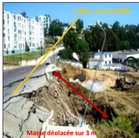
Photos.23,23 bis : Glissement de terrain, Cité des 160 logements (sur les hauteurs de la ville de Jijel)
