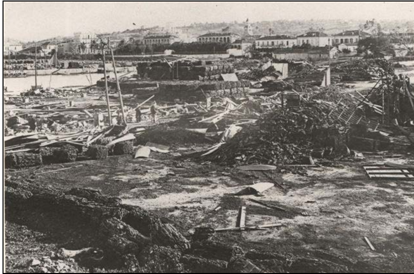
Photo.3 : Cyclone de Jijel 1928, vue générale de la ville et du port
