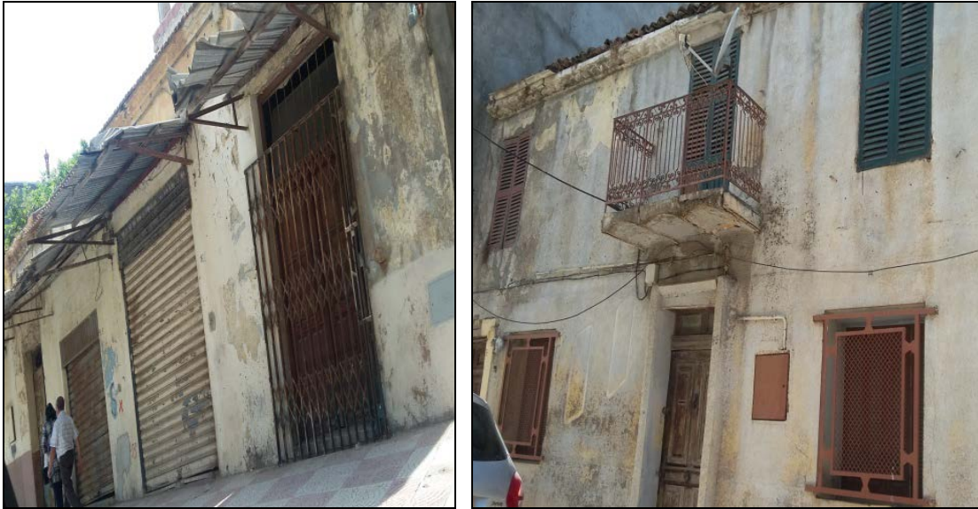
Photos. 63,64: Les vieilles maisons basses du centre ville.
