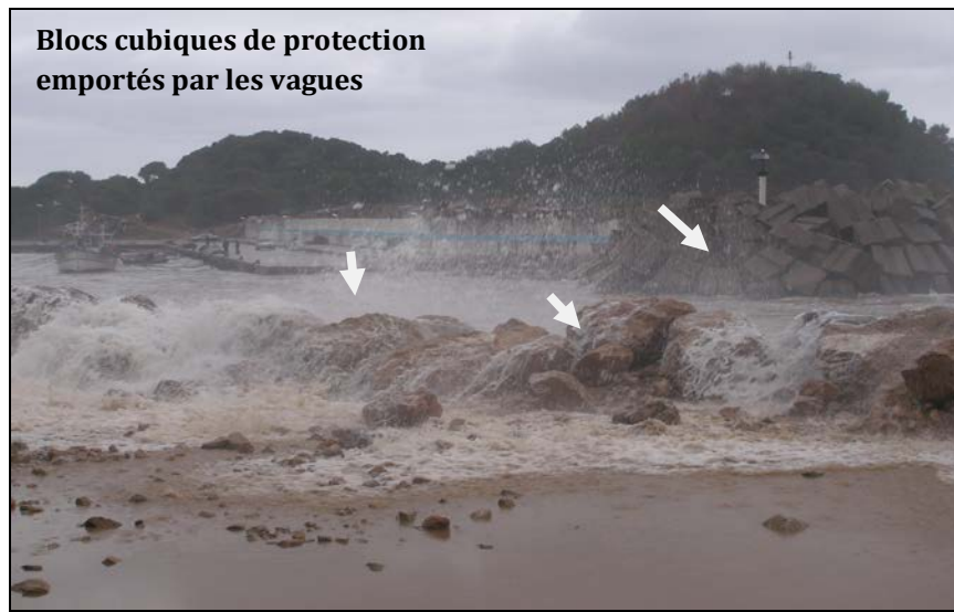
Photo.50 : Les blocs cubiques de protection du port de Ziama Mansouriah déplacés et emportés par l'énergie de la houle (en 2009) avant même leur mise en place finale.
