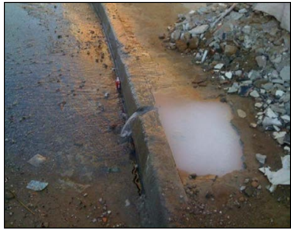
Photos.14,15: Fuites du réseau AEP (cité Ben Achour sortie Ouest de la ville de Jijel)
