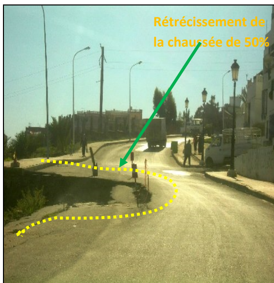
Photos.23,23 bis : Glissement de terrain, Cité des 160 logements (sur les hauteurs de la ville de Jijel)
