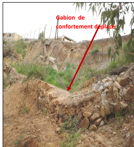
Photos. 24, 25: Glissement de terrain sur les hauteurs d'El Mekasseb (gabions déplacés)
