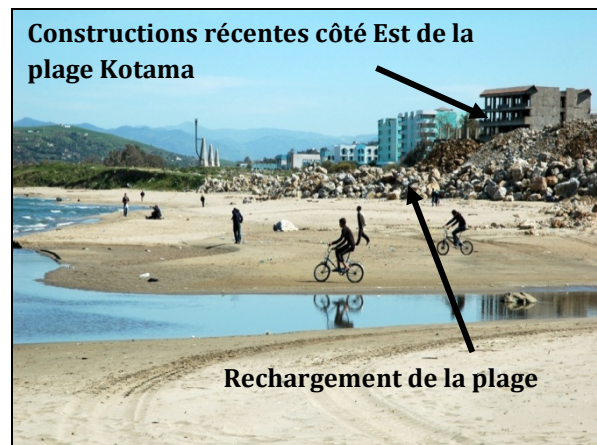
Photo. 59 : Rechargement de plage à l'Est Travaux de confortement.
