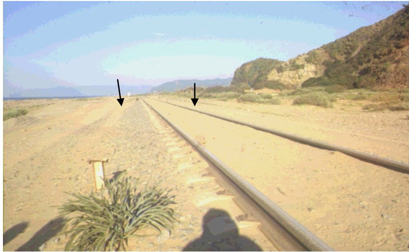
Photo. 45: Déflation sur la plage et ensablement de la voie ferrée à l'Est de Sidi Abdelaziz
