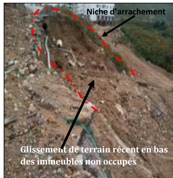
Photos.27, 28 : Glissement de terrain dans le site de Mezghitane
