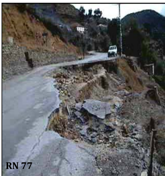
Photos. 33,34 : Glissements de terrain sur la RN 77 et sur le CW 135
