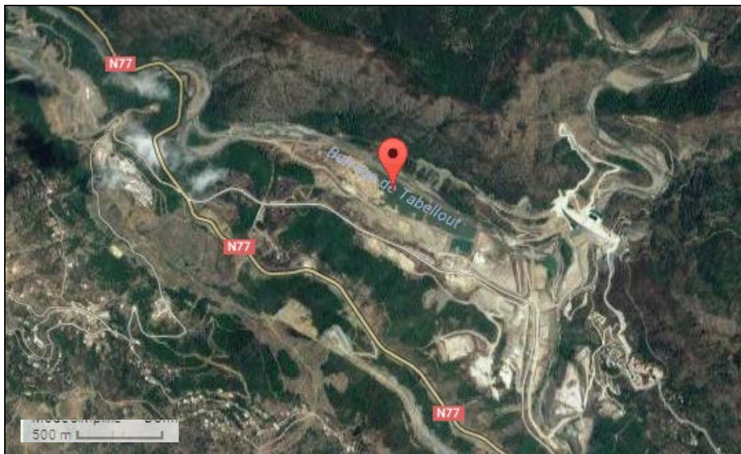
Photo .61 : Barrage de Tabellout en cours de construction (Google maps ; 2017).
