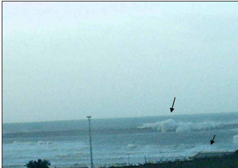
Photo.37: Franchissement des vagues de la digue Ouest lors de la tempête du (14.10.2004)
