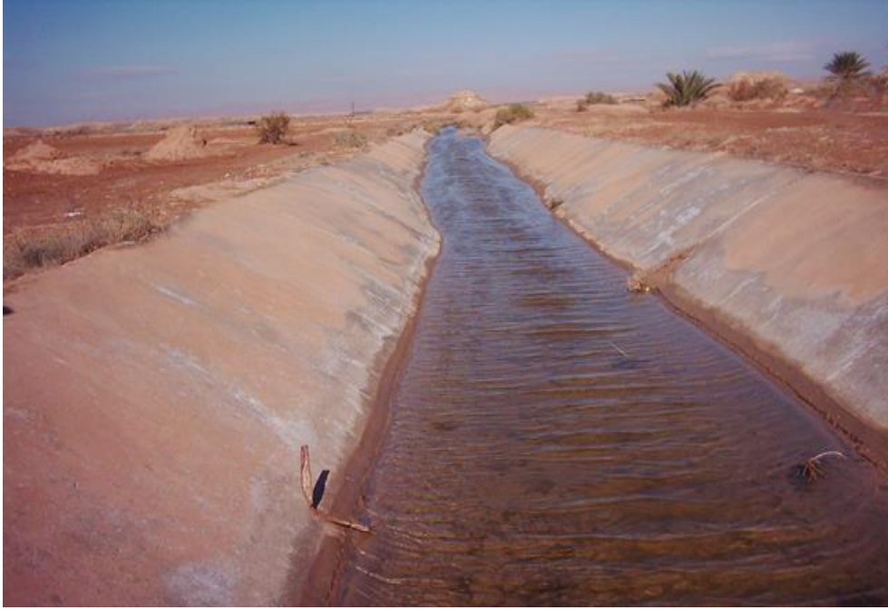
الصورة رقم -1- قناة صرف مياه السقي - ليوقة -
