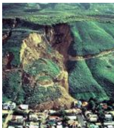
Figure I.2 : Phénomène de glissement de terrain
