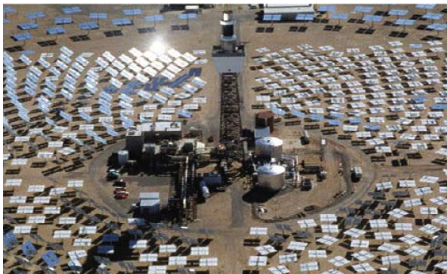
Figure II. 2. Centrale à tour solaire [3].
