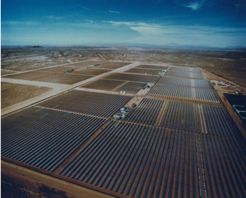
Figure II. 7. Les centrales solaires de SEGS III-SEGS VII en Californie [19].
