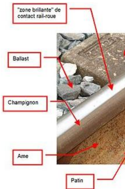
Figure II.9 : Description des composants de la voie ferrée [24]
