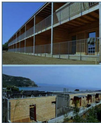
Figure I.11 : Bâtiment d'hébergement de l'IESC en Corse
