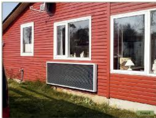
Figure IV.22f. Intégration en allège de la fenêtre
