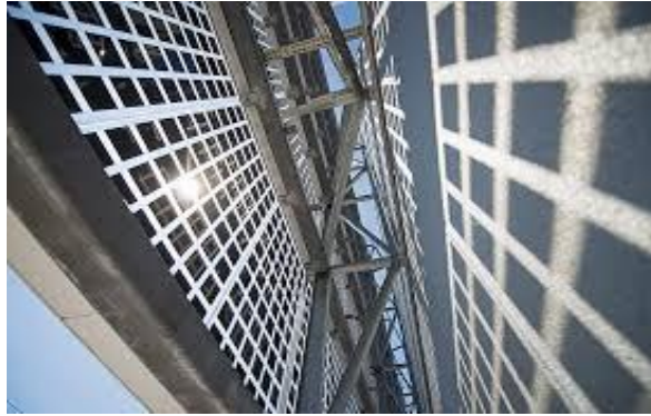
Figure IV.22c. Intégration en double peaux
