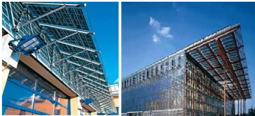
Figure IV.22a. Intégration de type brise soleil
