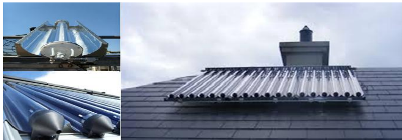
Figure I.12. Collecteur solaire CPC [7]
