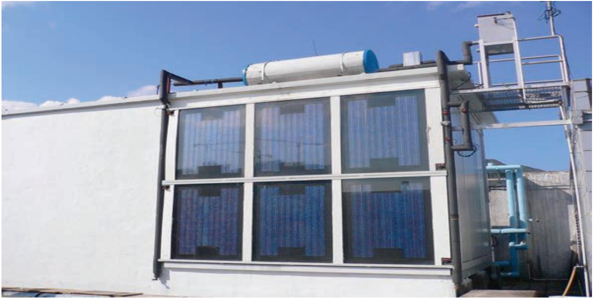
Figure I.12. Photo de la configuration des capteurs PV / T à eau (Université de Hong Kong, Chine) [18].
