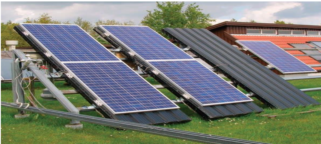
Figure I.11. Photo de la configuration des capteur PV / T à air (Ivan Katic, Danemark)[18].
