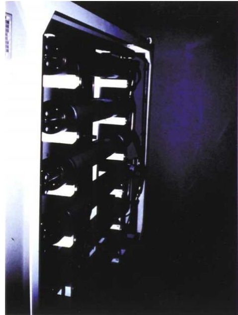
(b) Modules d'osmose inverse
