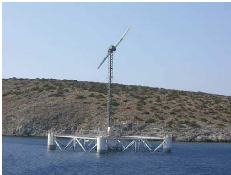
Figure IV.11 : Vue de la station de dessalement éolien/OI flottante à l'île d'Iraklia
