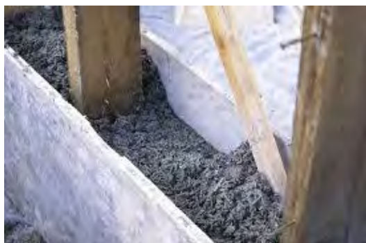
Figure 1.17. Béton de chanvre coulé sur place [62]
