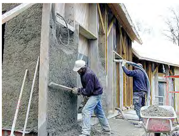
Figure 1.18. Béton de chanvre projeté [64]
