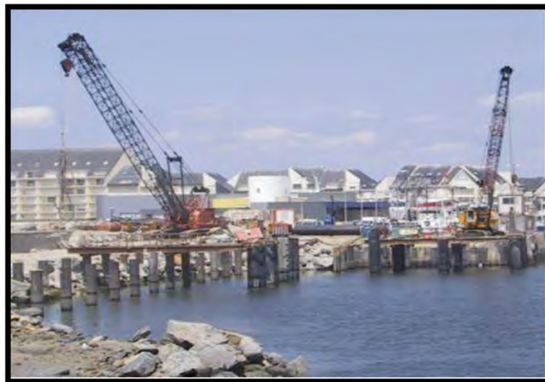
Figure II. 8. Pieux d'un port en cours de réalisation (Hermime, 2012) [9].
