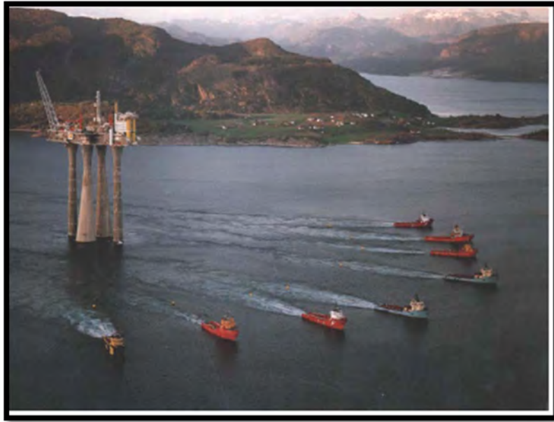
Figure II. 7. Exemple d'ouvrage de Plate-forme gravitaire (Tali, 2011) [2].
