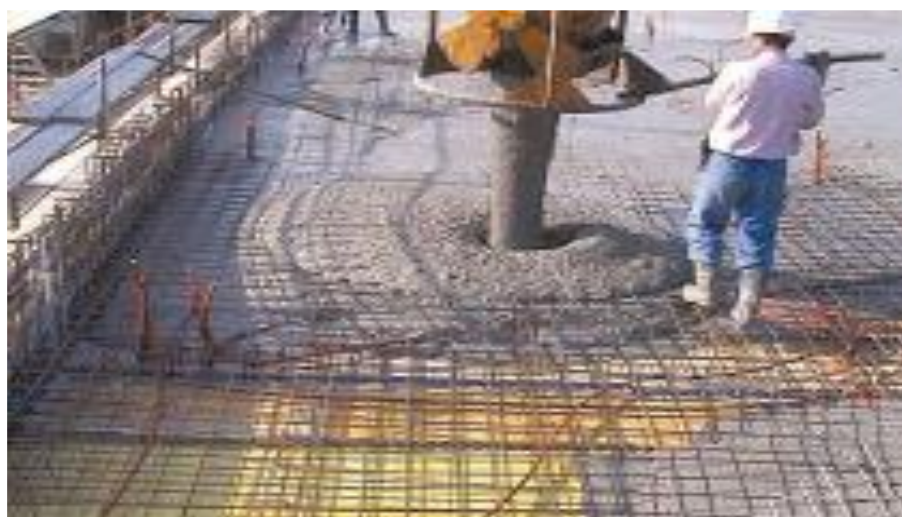
Figure I-1-3: Mise en place aisée du BAP par un seul ouvrier.
