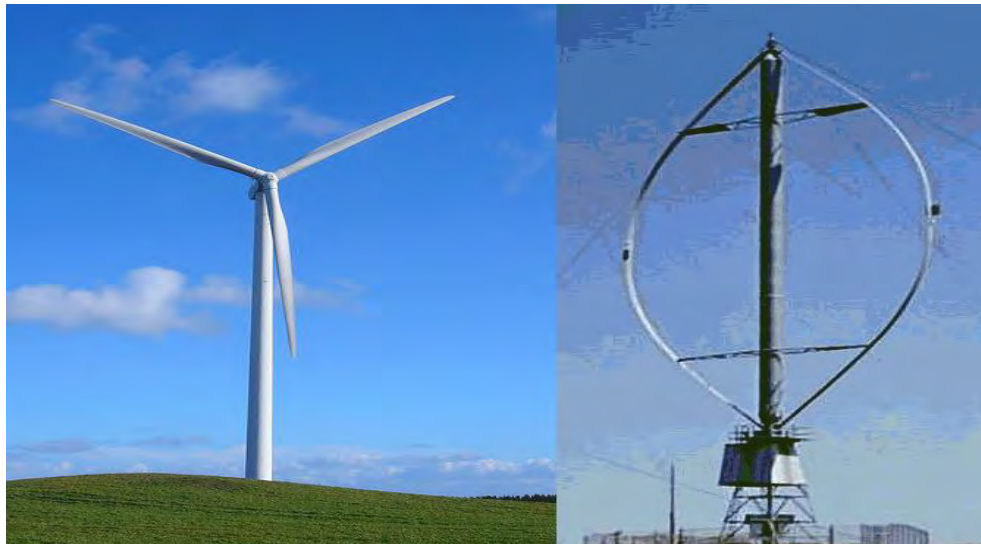
Figure 1.3 [21]: (a) gauche: éolienne à axe horizontal (b) droite: éolienne à axe vertical
